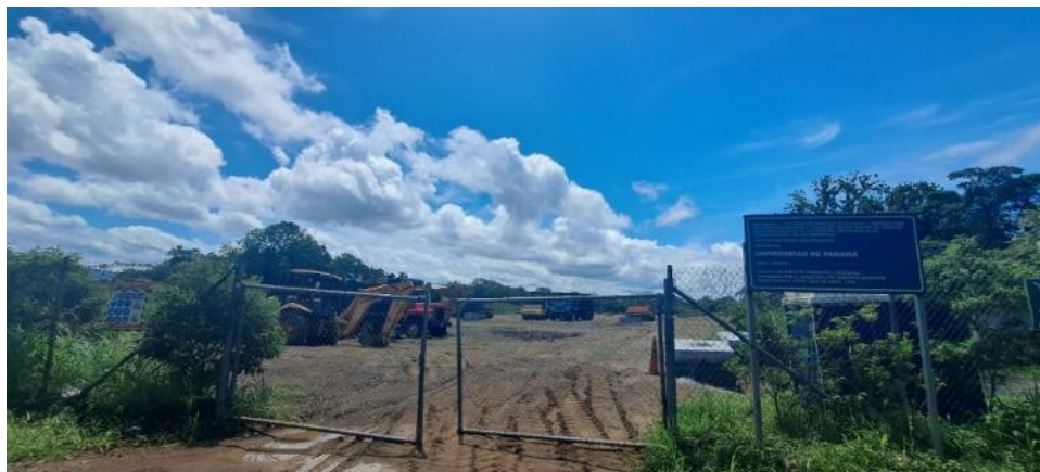
Figura 26. Vía para llegar al terreno se encuentra a 324.10 m del terreno destinado para el Proyecto del Bioterio.
