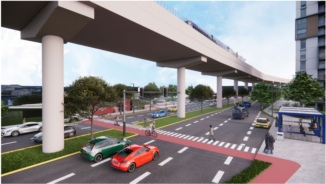
Figura 58. Vista general del proyecto. Elaboración propia.
