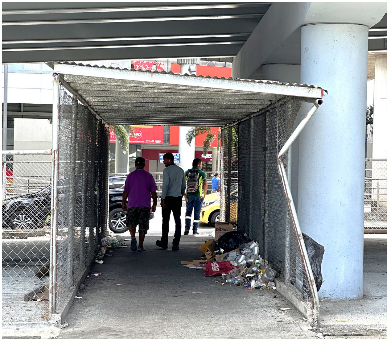
Figura 15. Fotografía de Peatones circulando bajo puente de San Miguelito. Elaboración propia.
