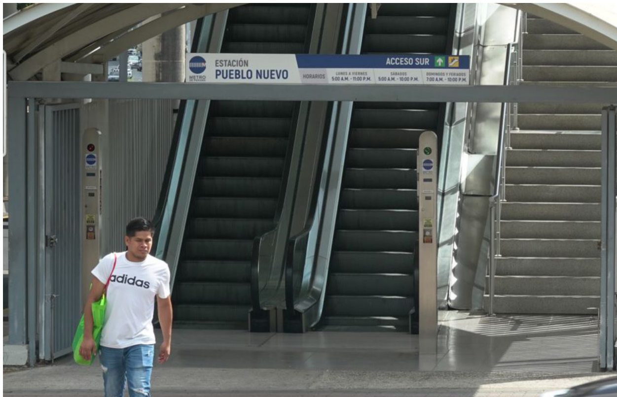
Figura 17. Metro de Panamá, Estación de Pueblo Nuevo en la Av. Simón Bolívar. Elaboración propia.
