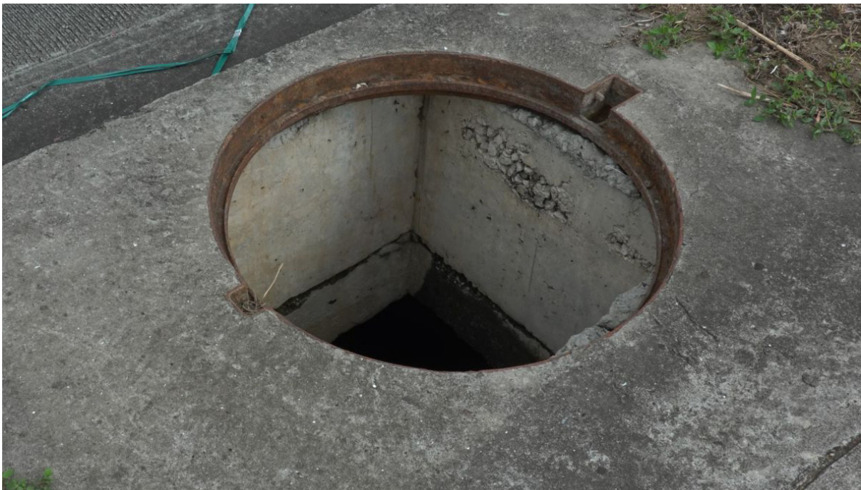
Figura 14. Condición de las aceras de la Av. Simón Bolívar. Elaboración propia.
