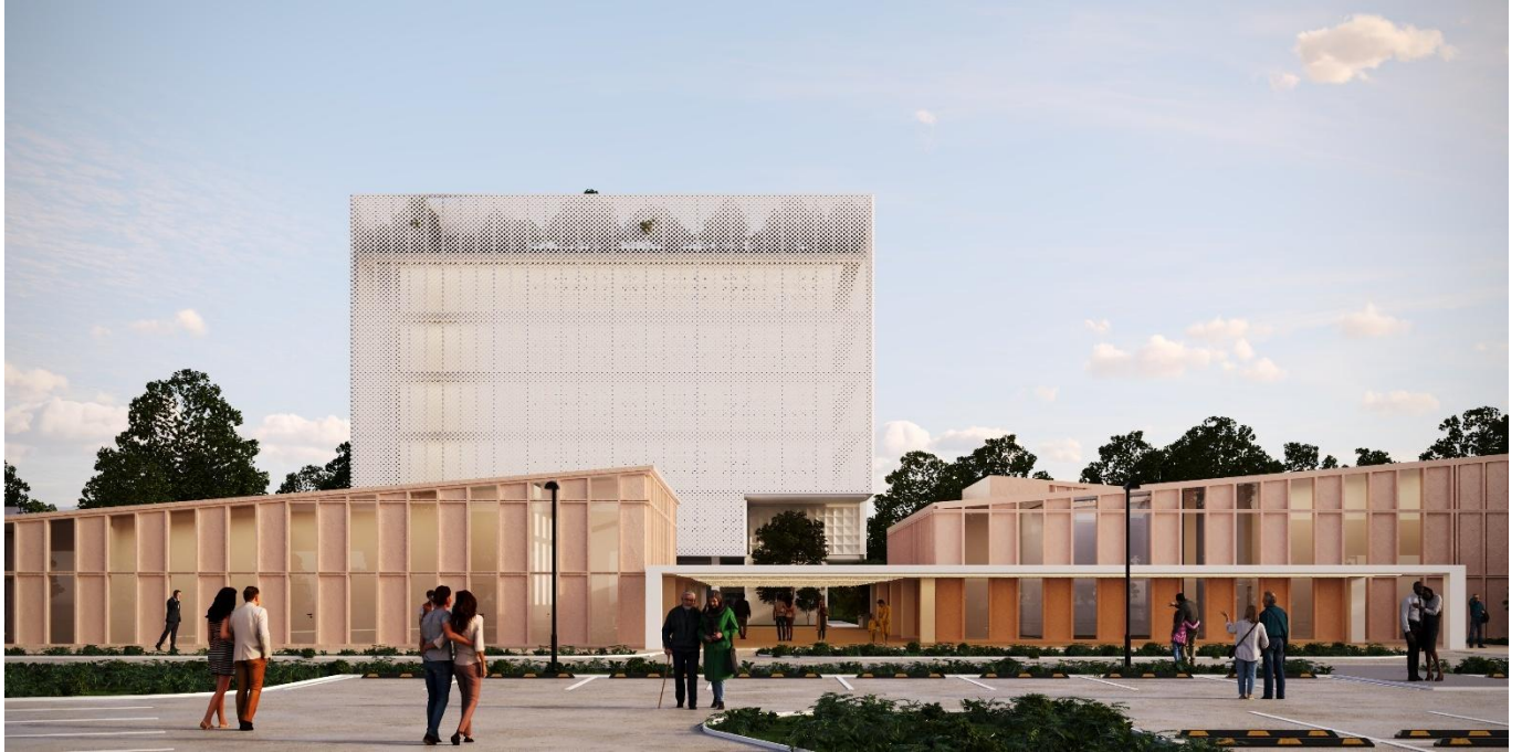
Imagen 57- Vista frontal del conjunto
