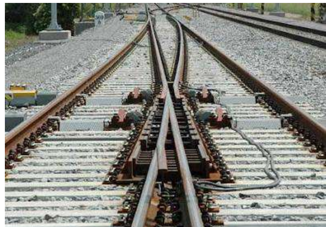
Ilustración 20. Desvíos y Cruces Fuente: http://www.agicorieles.com/Qu--es-el-desvio-de-ferrocarril-.html
