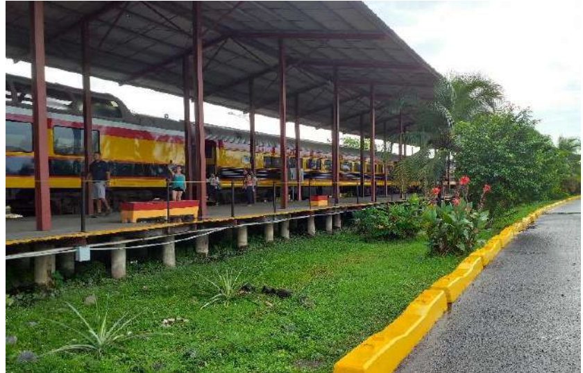
Ilustración 8. Estación en Colón Actual
