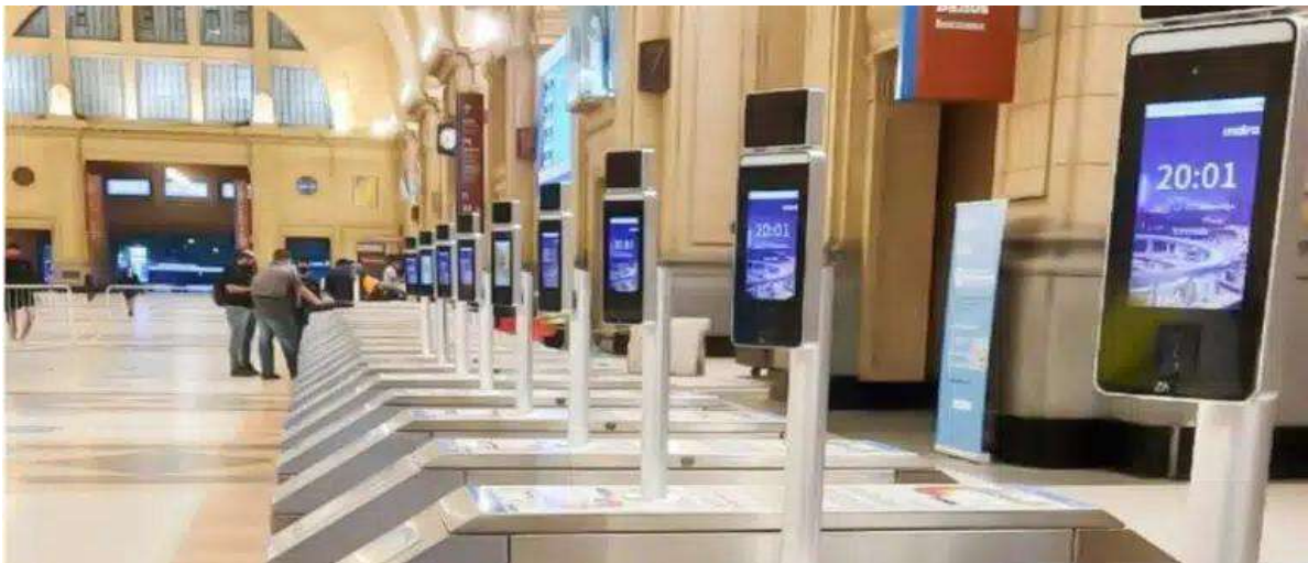
Ilustración. 59. Control de acceso integrado
