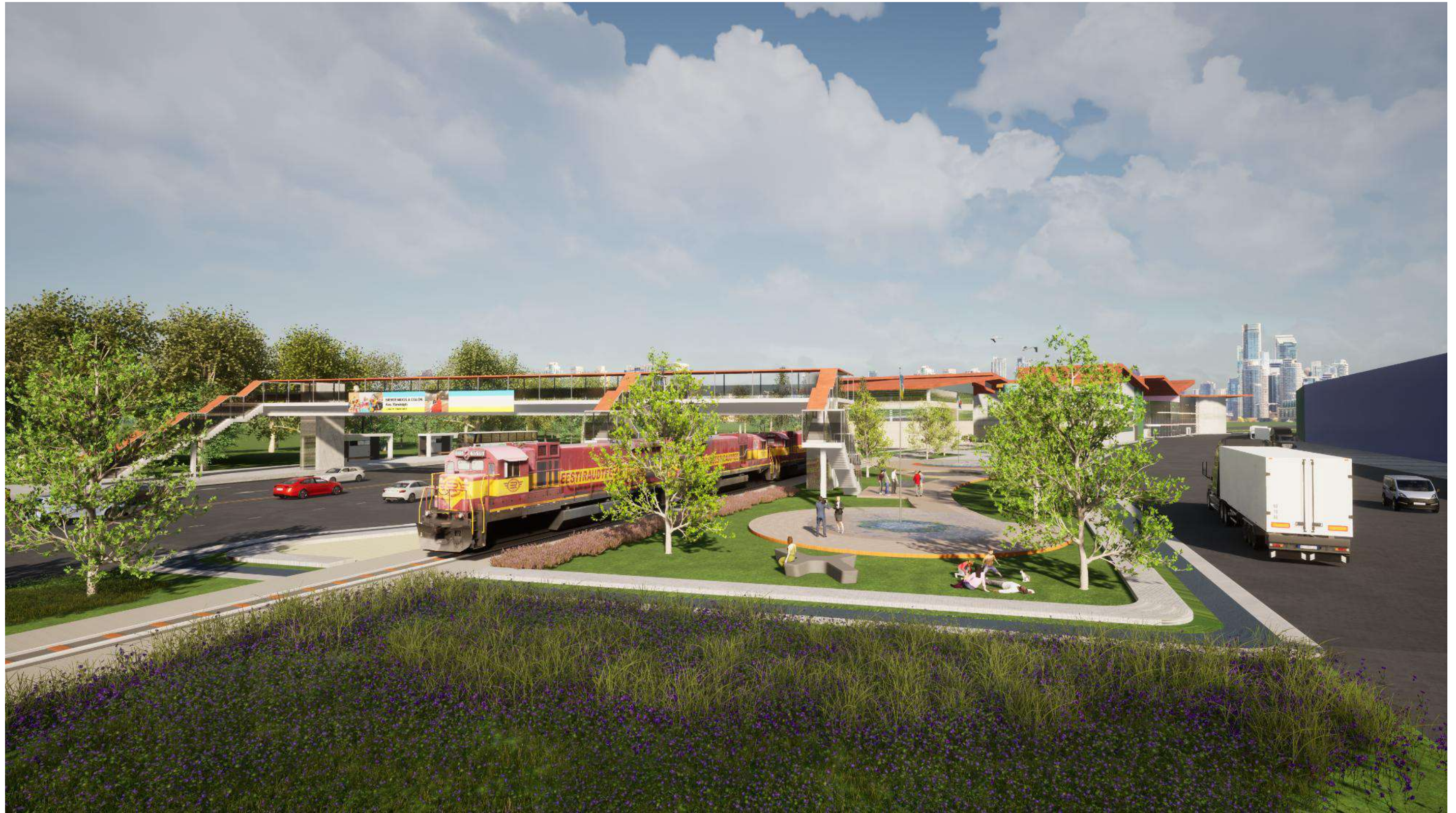
Vista exterior del proyecto
