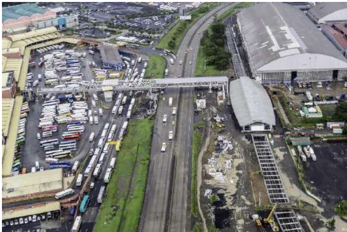
Ilustración 30. Vista superior de la estación
