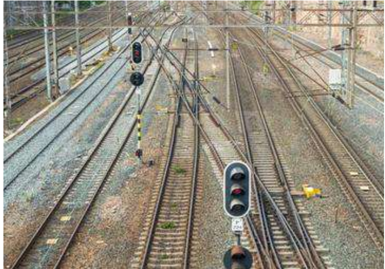
Ilustración 17. Señalización y control
