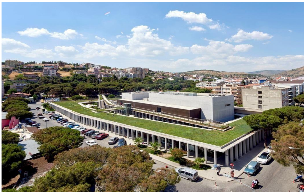
Imagen 16 Vista aérea del Centro Cultural
