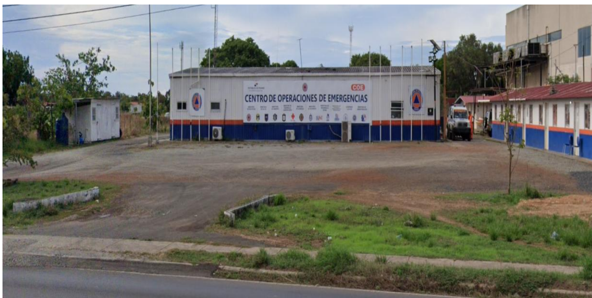
Imagen 31 Centro de Operaciones de Emergencias SINAPROC
