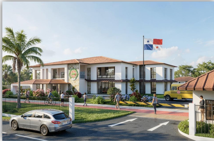
Vista frontal del Edificio Central
