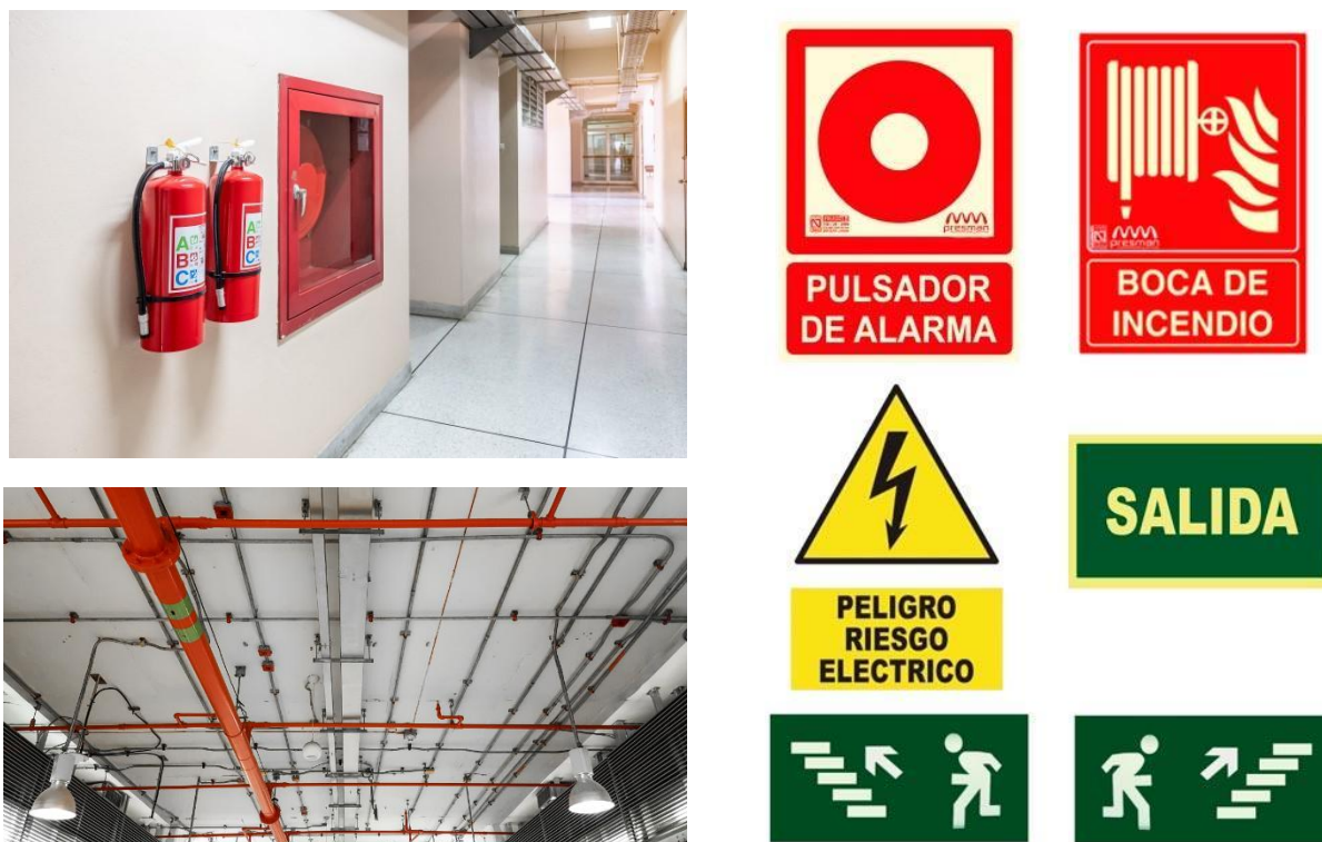
Ilustración 63. Sistemas contra incendios
