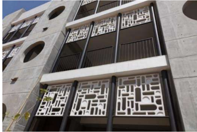
Figura 8. GRC Jali en Fachada
