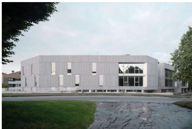
Figura 12. Vista frontal del edificio
