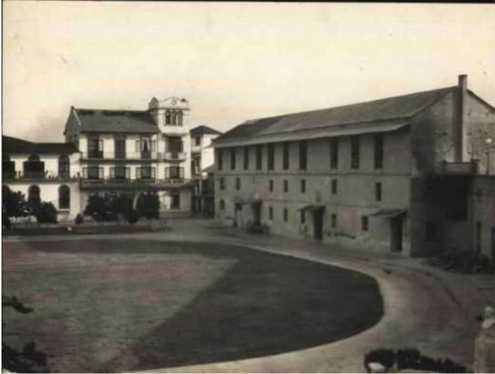
Figura 15: Se observa la nueva plaza de armas frente al cuartel justo antes de la demolición de este. Fuente: Delgado M. E. (2012). Vista frontal del Cuartel Chiriquí en las Bóvedas El edificio del INAC. https://www.facebook.com/Panamáysuhistoria/photos/a.311142725662801/311142732329467/
