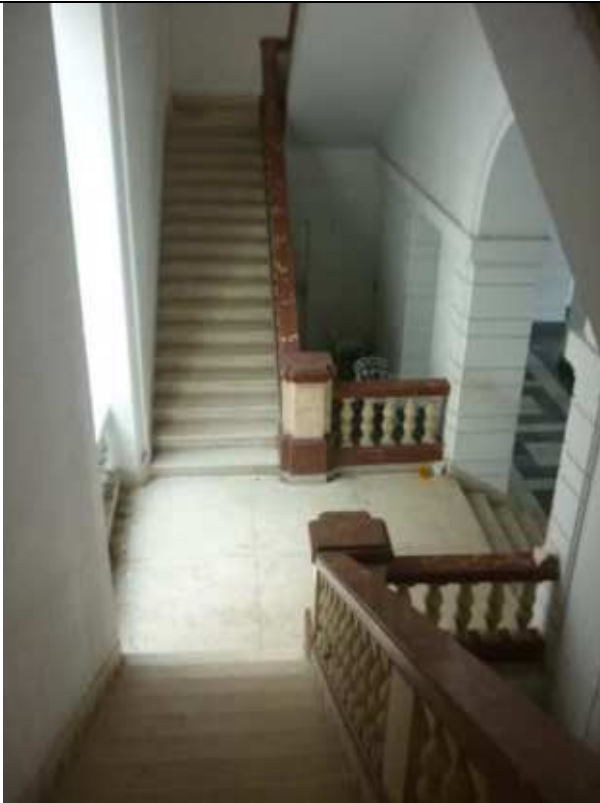
Figura 58: Arranque de escalera principal, Fuente: Autor.
