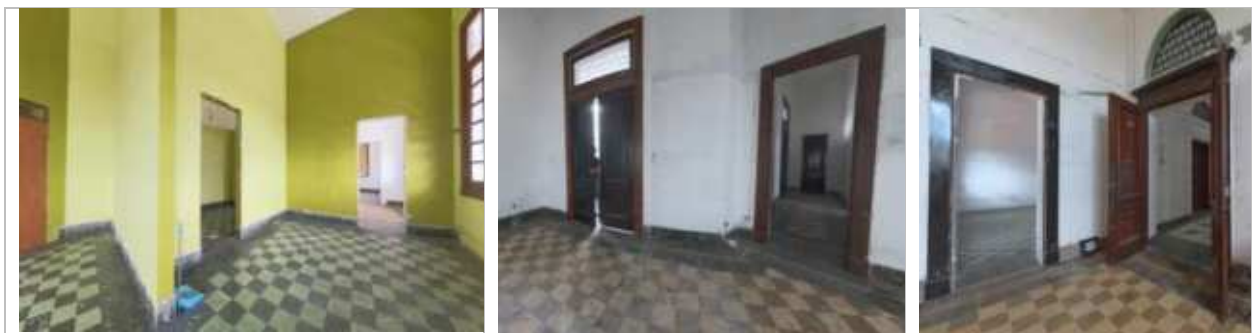
Figura 62: En estas escenas se observa como lo pisos definen los espacios. Aún se mantienen la mayoría de los pisos de pastas permitiendo la lectura de los espacios originales. Fuente: Autor.
