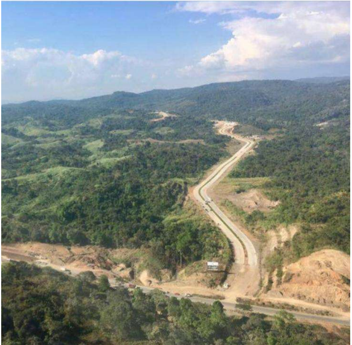
Figura 21. Vista aérea de accesos al proyecto.
