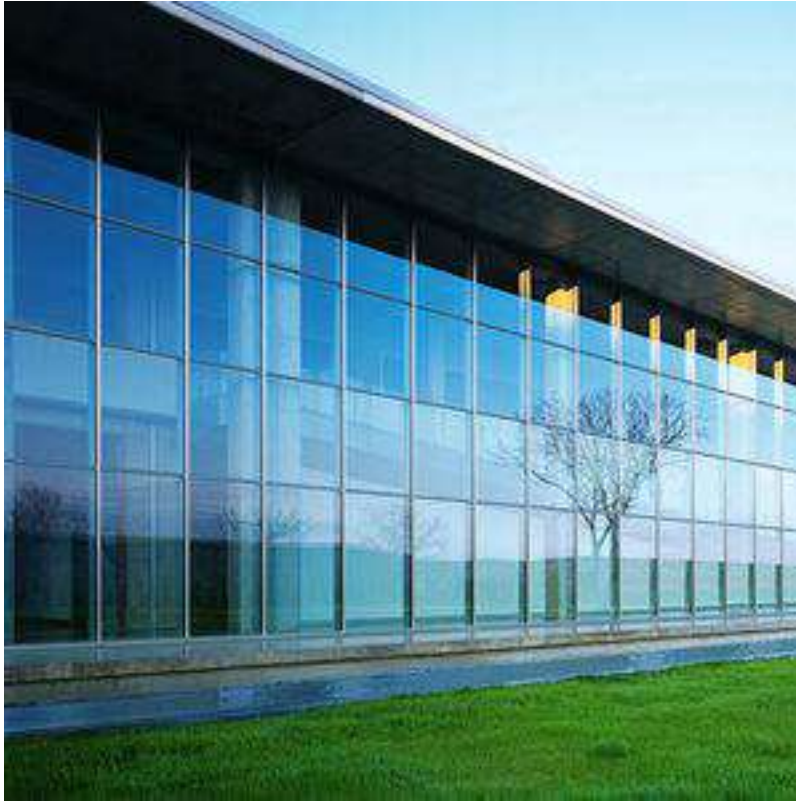
Figura 22. Paneles de vidrio
