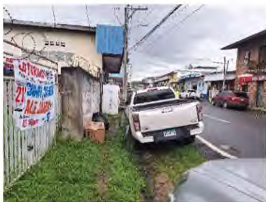
Ilustración 28: Ausencia de acera Autor: Fotografiado por el autor
