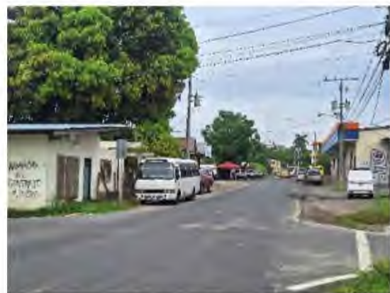
Ilustración 36: Ausencia de cunetas.
