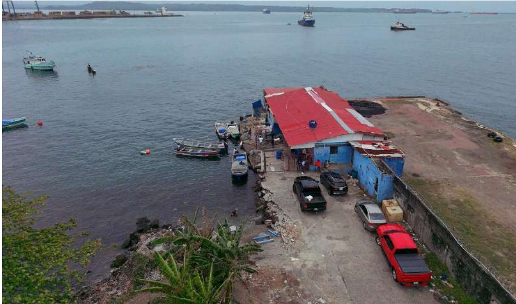
Ilustración 48 Vista aérea del muelle fiscal existente próximo al terreno.
