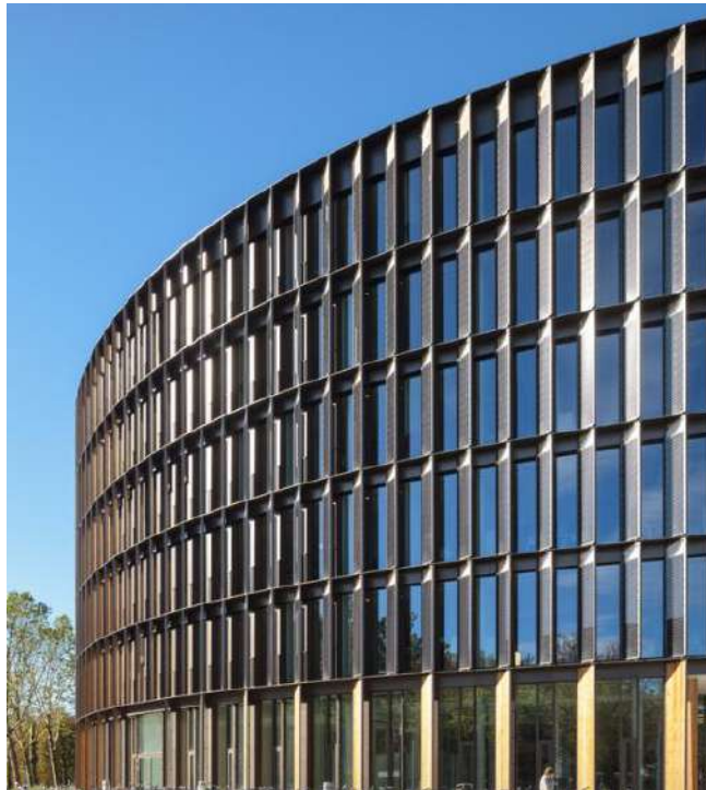
Ilustración 28 Edificio sostenible Freiburg Town Hall, paneles solares en ventanas.
