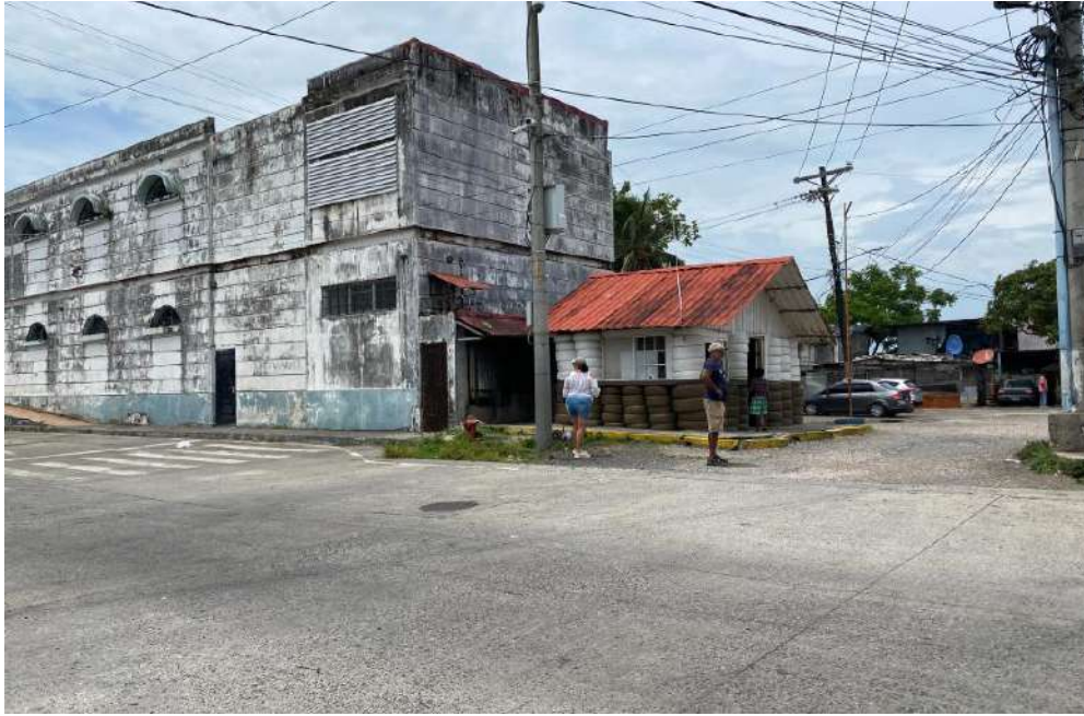
Ilustración 44 Vista desde Avenida del frente entrada posterior al terreno de calle no pavimentada.
