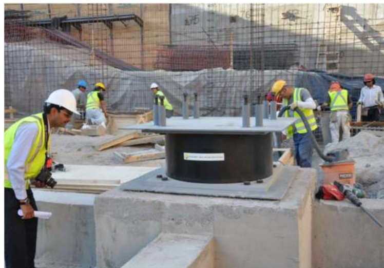
Ilustración 50: Instalación de aisladores sísmicos y vigas. Fuente: briannunezconstruccion, 2015
