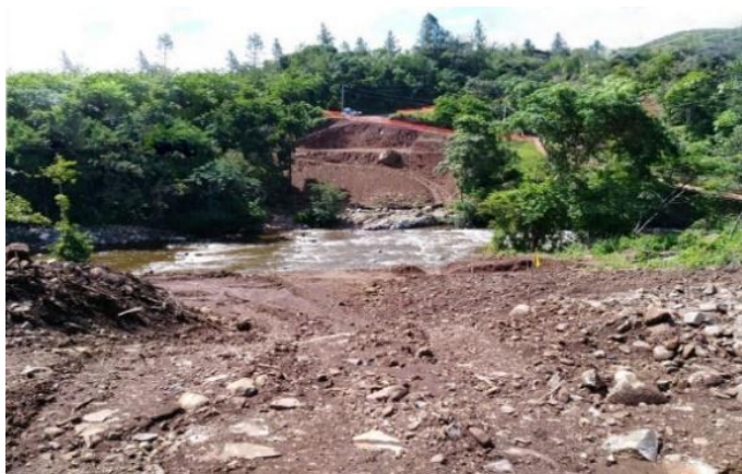
Ilustración 38. Trabajos de movimiento de tierra para nuevo puente - Fuente: Moreno, E.
