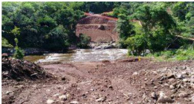
Ilustración 16. Movimiento de tierra, nuevo puente sobre río Tabasará - Fuente: Moreno, E.
