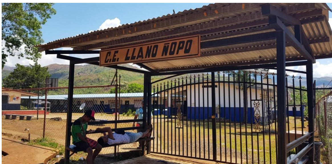
Ilustración 12. Centro Escolar Llano Ñopo - Cerca perimetral - Fuente: Moreno, E.
