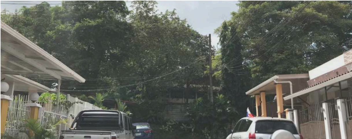
Imagen 3.16. Muro que divide el colegio Ángel Rubio de la urbanización Colinas del Golf. Elaboración propia.
