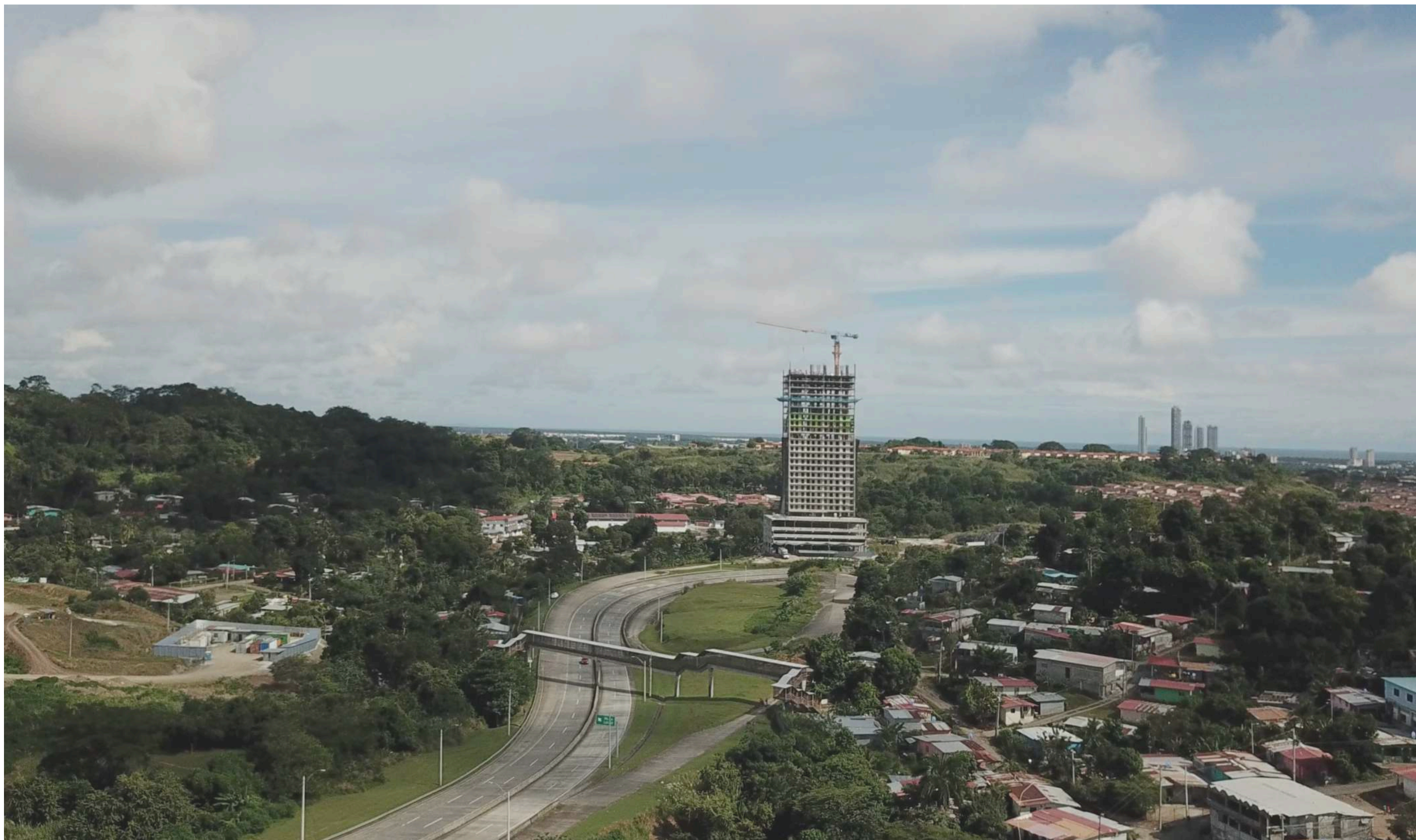
Imagen 3.18. Vista aérea de El Sector. Elemento Fragmentador 2: Ave. Rafael Alemán. David Riquelme.
