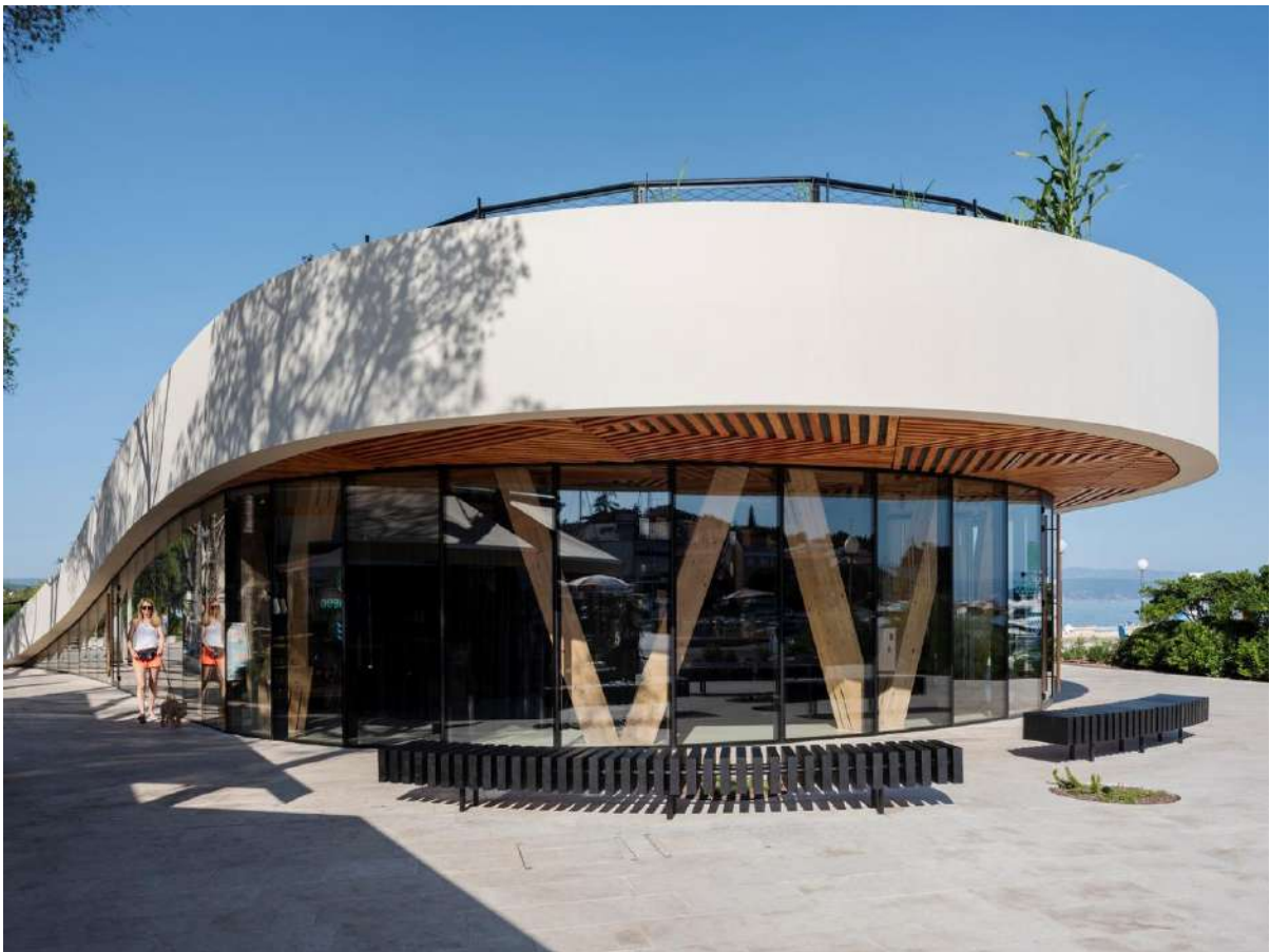
Ilustración 47. Vista frontal de Centro de Interpretación del Patrimonio Marítimo DUBoak / NFO
