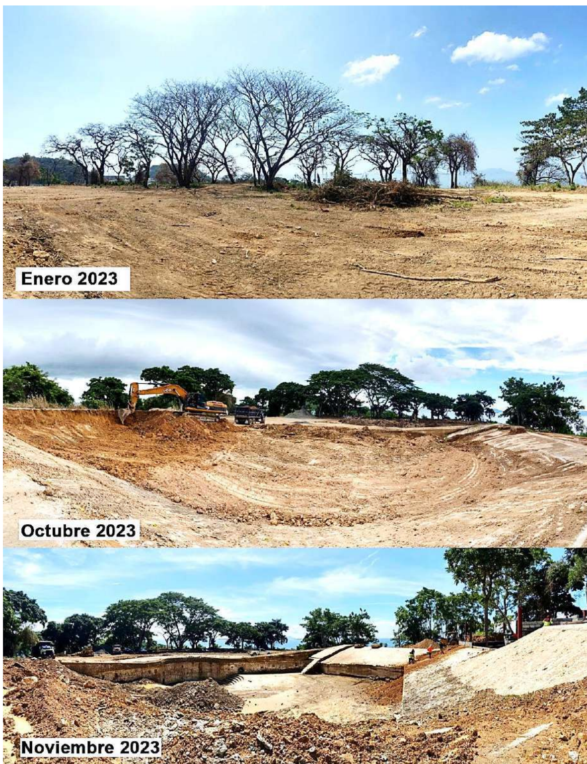
Fotografía 9: Trabajo de apertura del búnker N°1 de Isla Naos.
