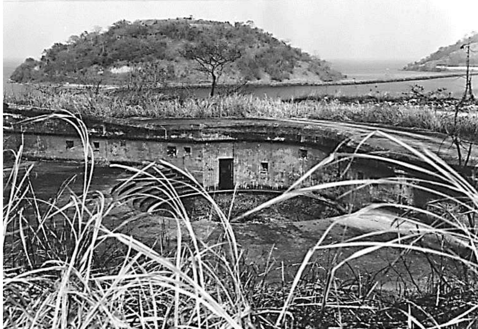
Ilustración 13: Posición del cañón N° 2, Batería Buell, Isla de Naos, mirando al sureste. Esta es una posición típica para los rifles de carro que desaparecen.
