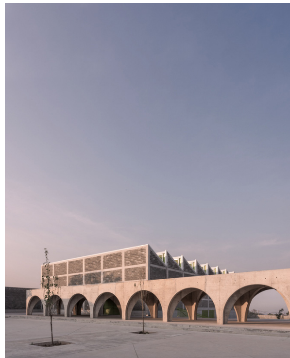
IMG_008. Vista hacia eficio deportivo .©Arturo Arrieta.
