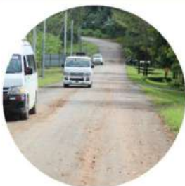
Imagen 19: Carretera Santiago-Mariato los trabajos de nueva carretera.
