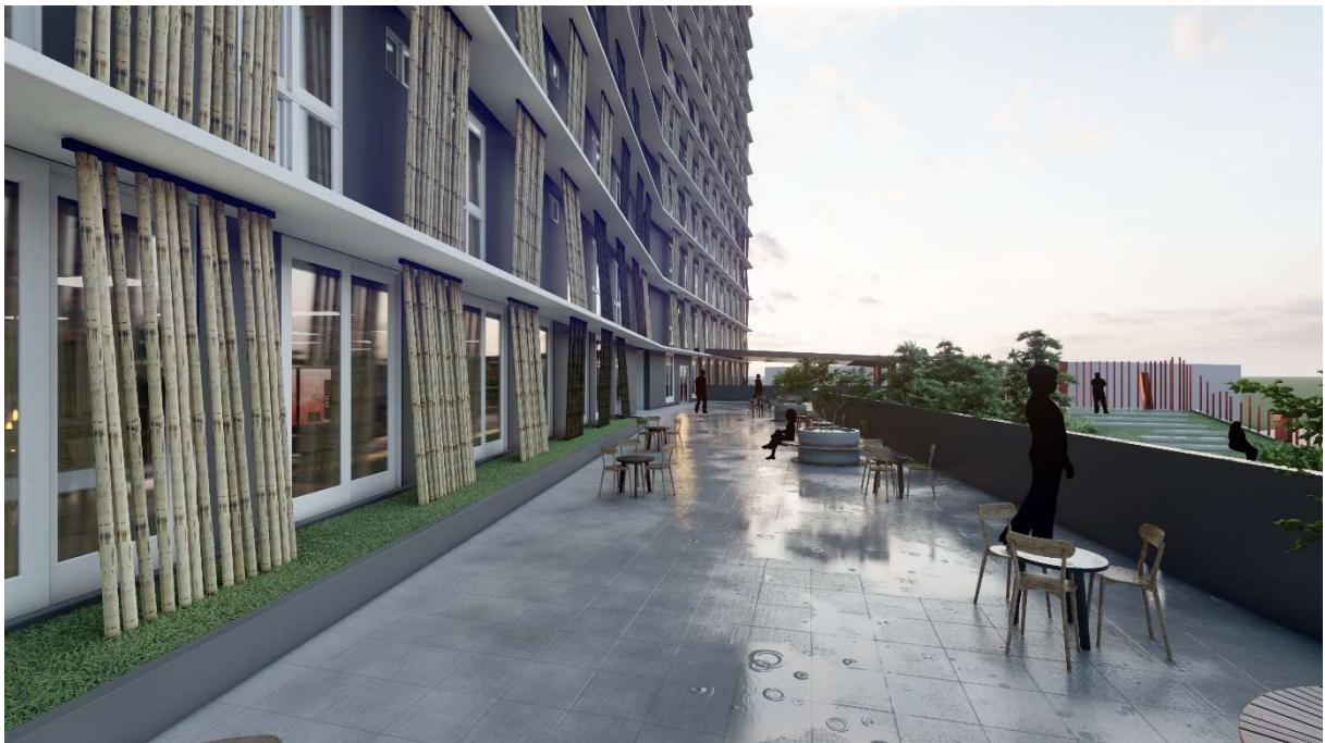
Imagen 58. VISTA DE TERRAZA SUR (NIVEL 100)
