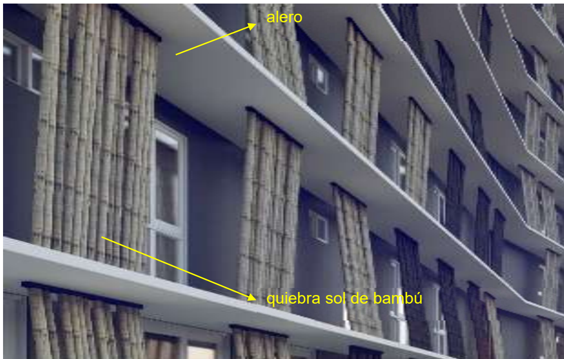
Imagen 75. Aleros y quiebra sol en la fachada del residencia estudiantil UP, 2022, Panamá, fuente: Autor
