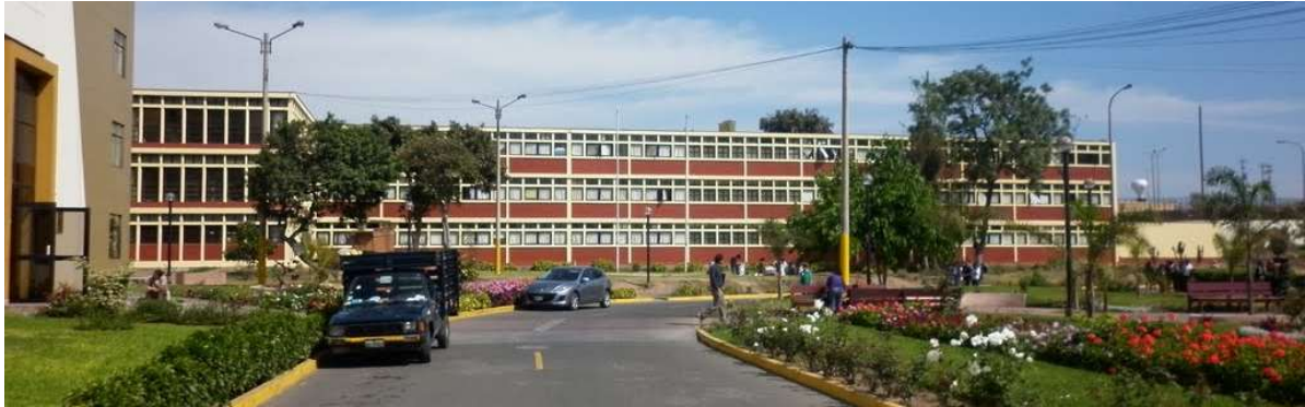
Imagen 21. Fachada frontal Mayor de San Marcos, Perú, fuente: http://unmsm.edu.pe/ , 2016
