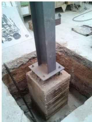
Figura 50. Zapata, Fuente: https://www.habitissimo.com.mx/ (2021)
