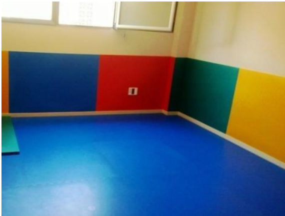
Figura 59. Pared acolchonada, Fuente: Guía para proyectar y construir escuelas infantiles, 2012.
