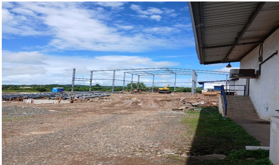
Figura 4. Avance de la construcción de la bodega
