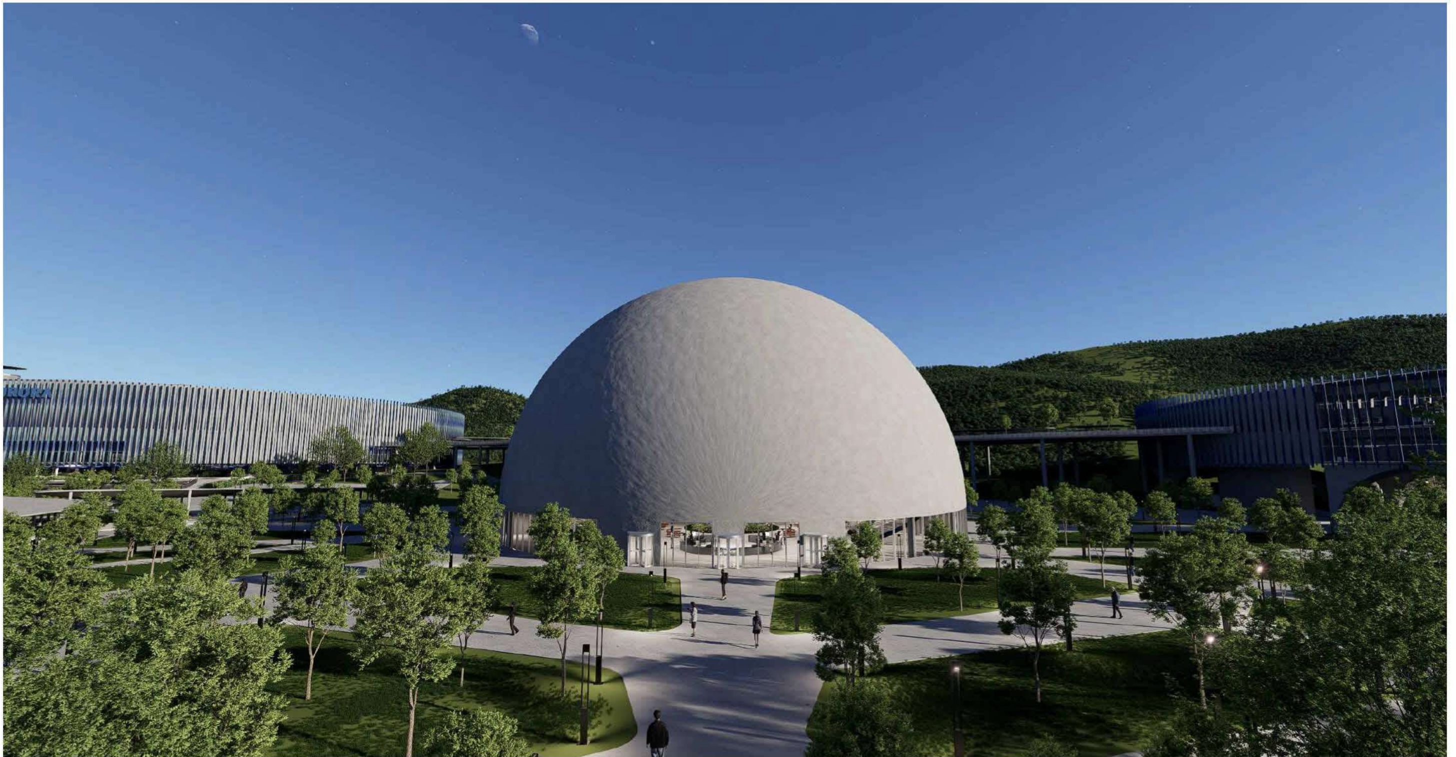
Imagen 4.43. Vista de la fachada del planetario.
