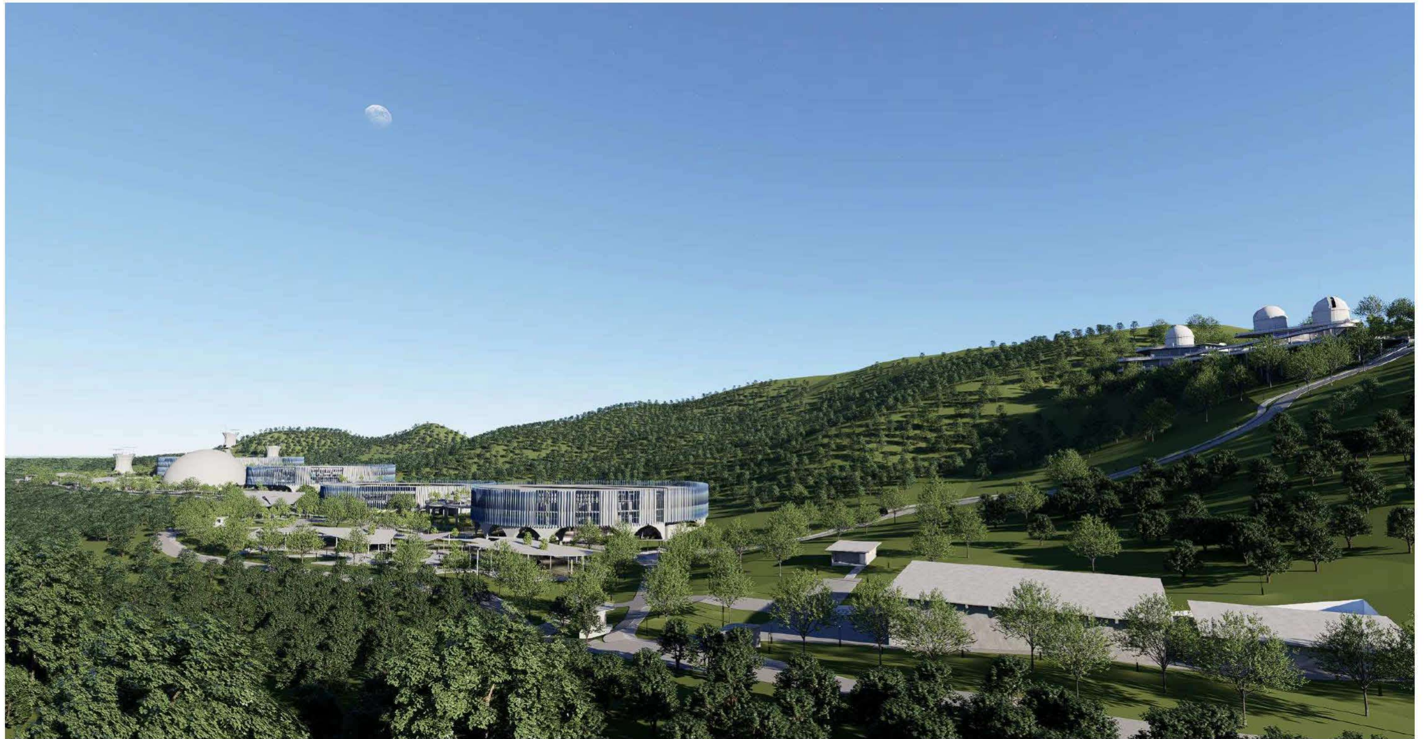
Imagen 4.13. Vista aérea general frontal del conjunto del proyecto.
