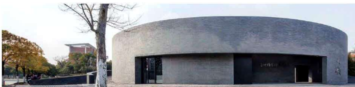
Imagen 2.48. Parque Astronómico de la Escuela Secundaria Zhenze, China (2018) Fotografía: Hengzhong LYU.
