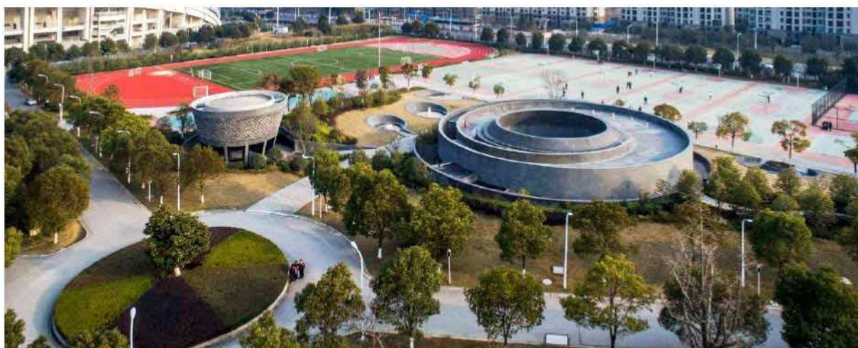
Imagen 2.49. Parque Astronómico de la Escuela Secundaria Zhenze, China (2018) Fotografía: Hengzhong LYU.
