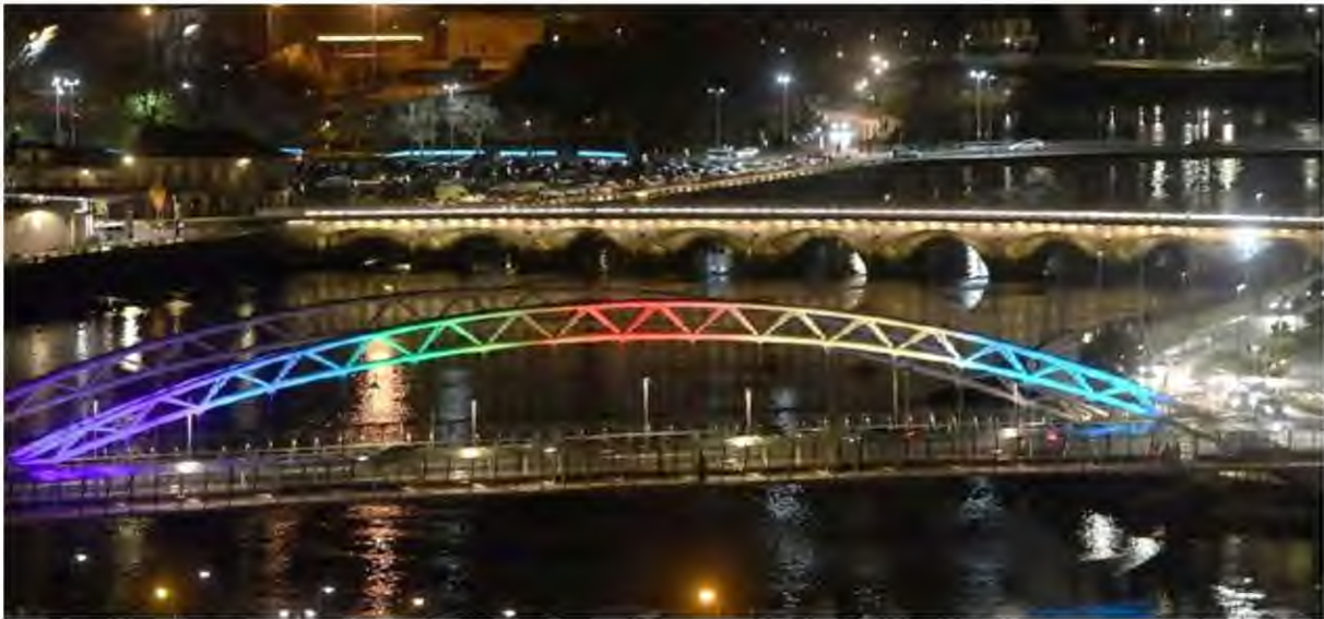
Ilustración 93. Puente de las Corrientes en Pontevedra, España. Fuente: Gustavo Santos, Faro de Vigo
