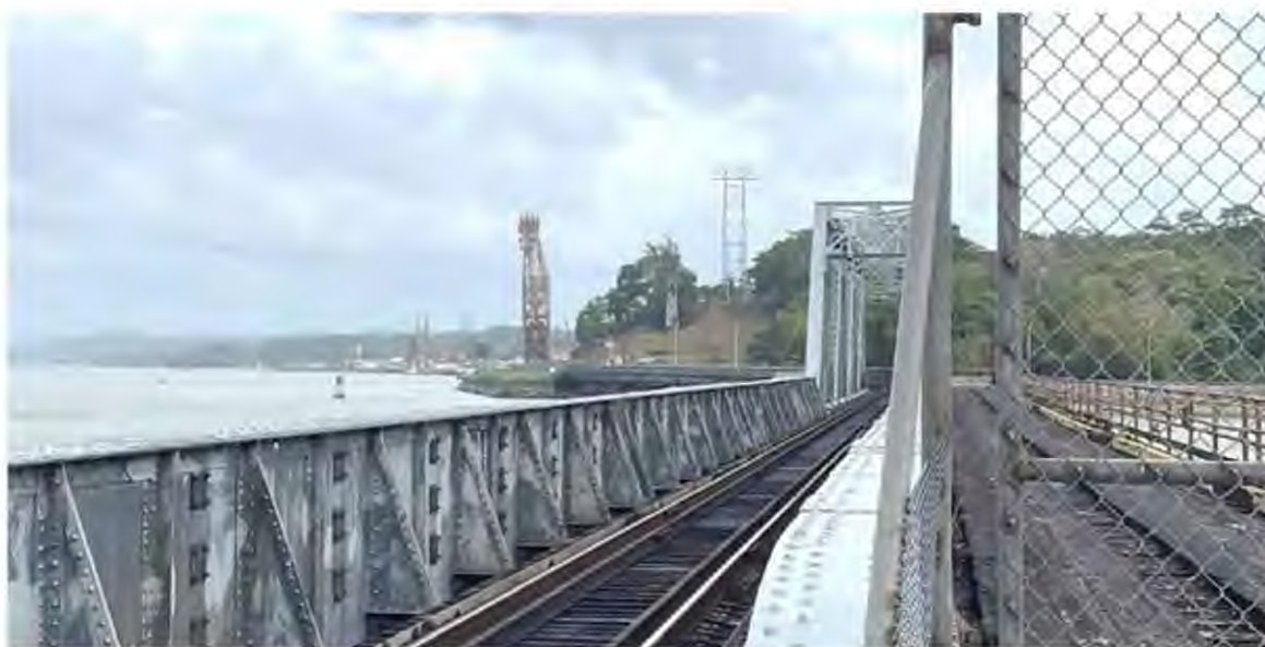
Ilustración 54. Vista desde la orilla Este del puente del ferrocarril. Fuente: Autoría propia.
