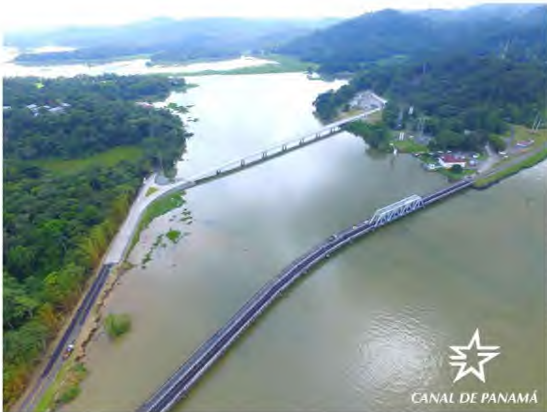
Ilustración 33. Nuevo puente de Gamboa (2018). Fuente: Autoridad del Canal de Panamá.
