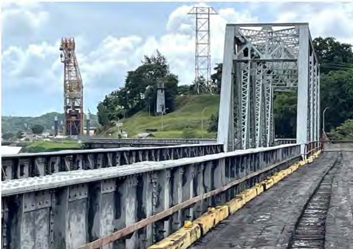
Ilustración 46. Puente del ferrocarril de Gamboa. Fuente: Autoría propia.
