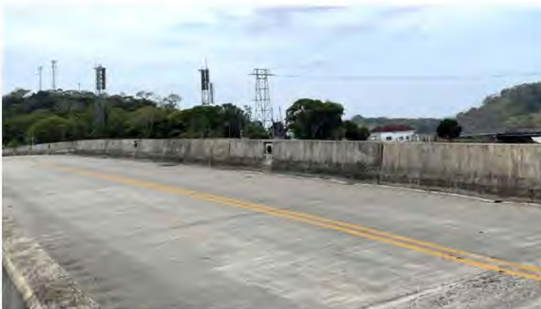
Ilustración 55. Puente nuevo de Gamboa. Fuente: Autoría propia.
