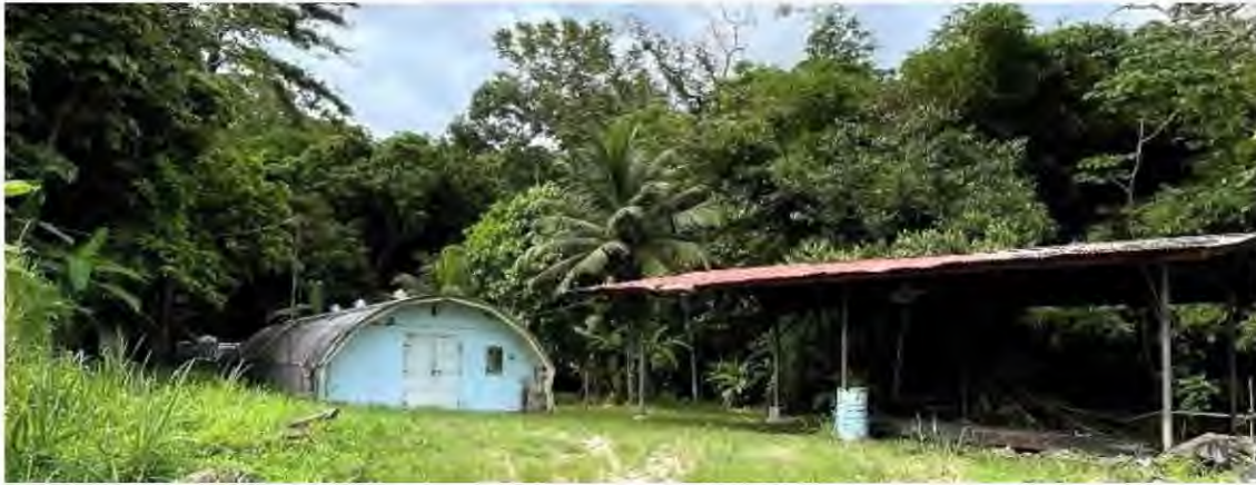
Ilustración 48. Depósito de herramientas de mantenimiento. Fuente: Autoría Propia.
