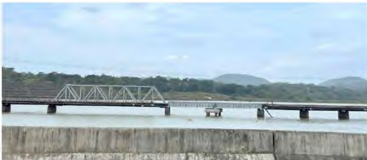
Ilustración 53. Vista desde el puente nuevo de Gamboa. Fuente: Autoría propia.
