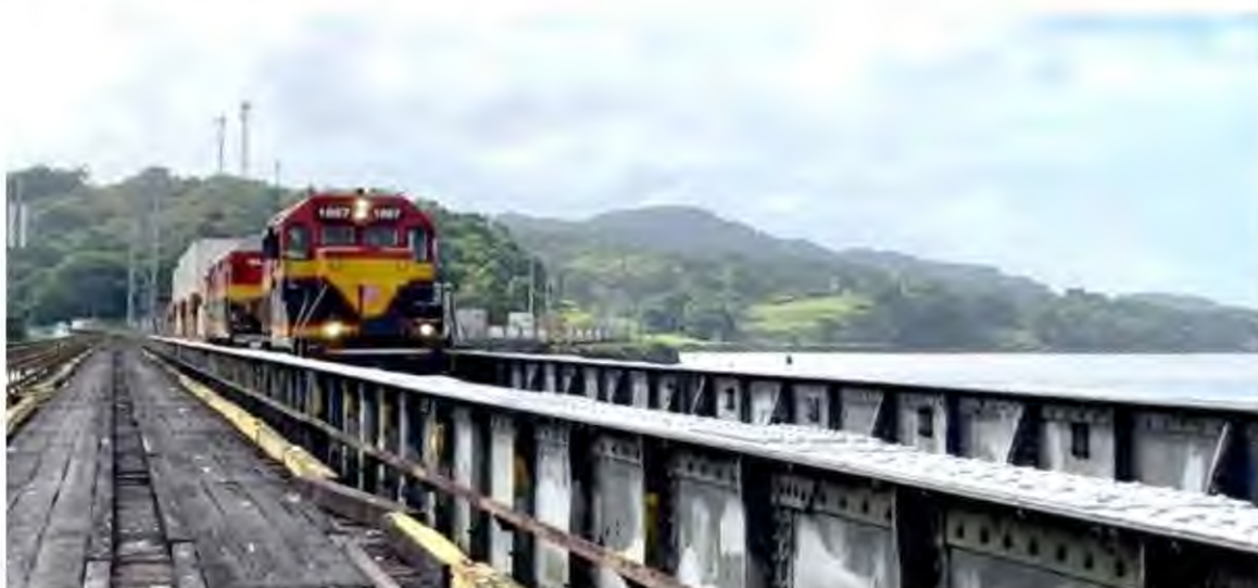
Ilustración 59. Locomotora cruzando el puente. Fuente: Autoría propia
