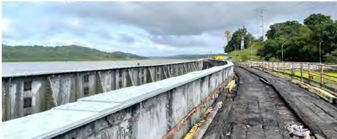
Ilustración 57. Línea de observación dinámica: Recorrido por el puente del ferrocarril.
