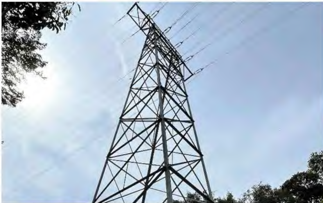
Ilustración 47. Torre de telecomunicaciones. Fuente: Autoría propia.
