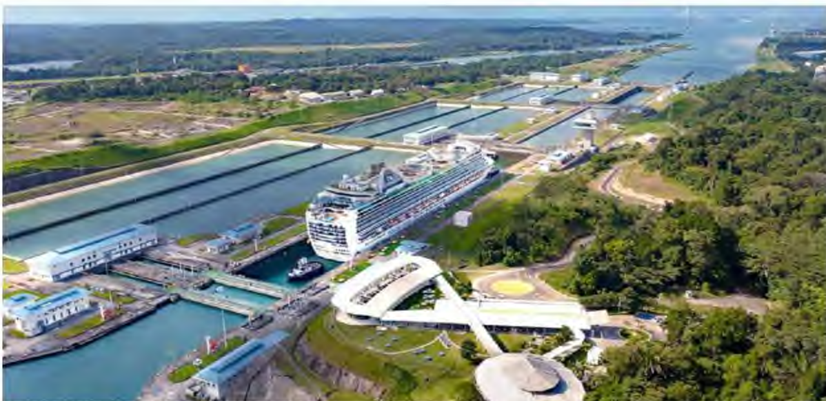
Ilustración 3. Centro de Visitantes de Agua Clara, Canal de Panamá (2022). Fuente: Revista El Faro.
