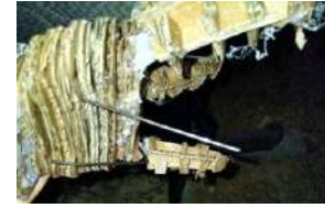
Ilustración 28. Vista de los alambres de reforzamiento, que atravesaban las piezas.
