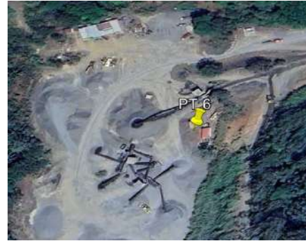
Fig. No.31. Punto#6 vista desde Google Maps.
