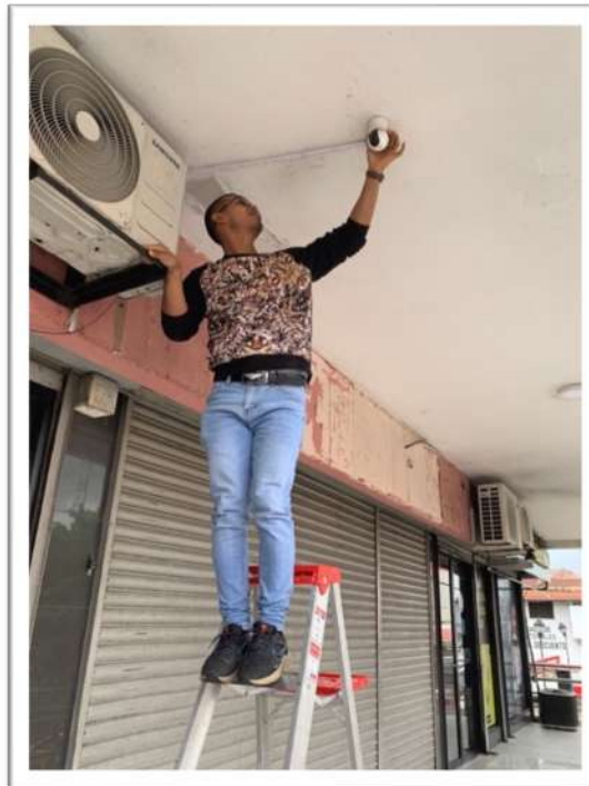
Imagen 13. Instalación de cámara fuera del local.
