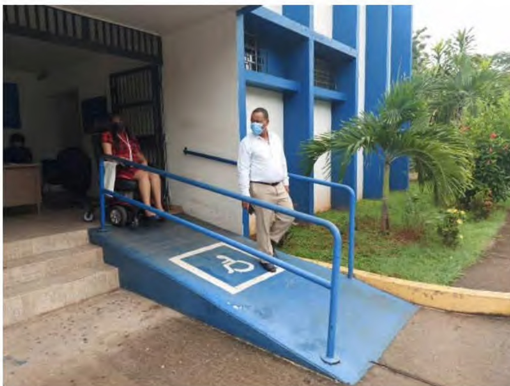
Imagen 15. Rampa inadecuada
