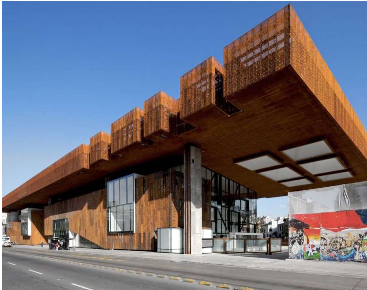
Imagen 12. Fachada Norte © Nico Saieh
