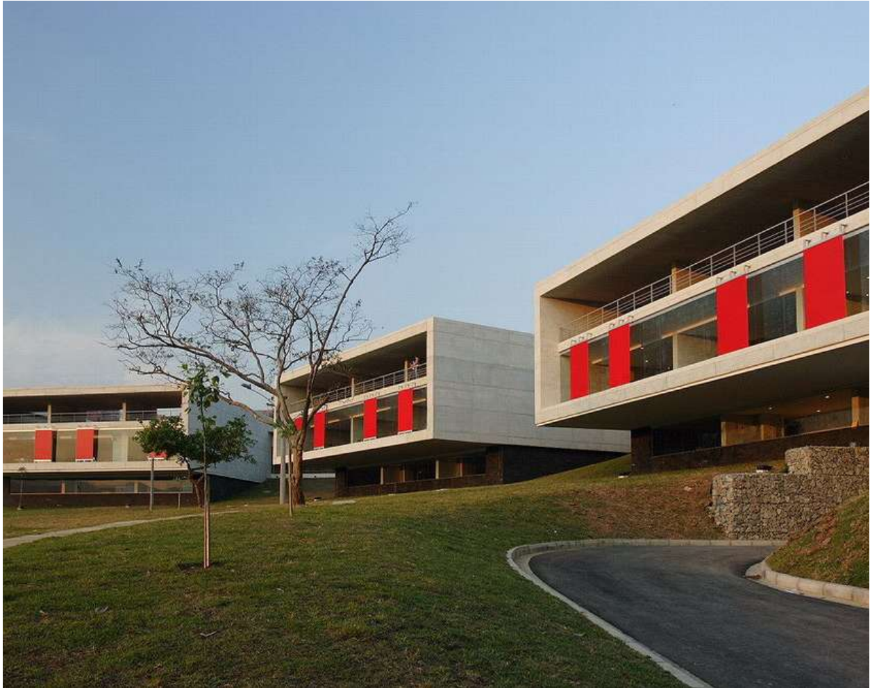
Imagen 18. Fachada frontal © Fill Medellín
