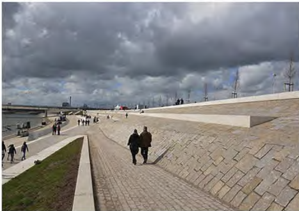
Ilustración 22.1. Espacio generado en la zona norte, paralelo al nuevo cauce Spiegelwaal.
