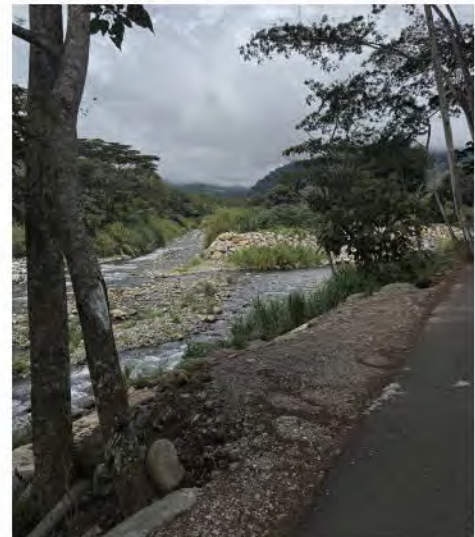
Ilustración 65. Intersección entre río Caldera y Pianista sometido a constantes dragados y construcción de muros de contención. Autoría propia.
