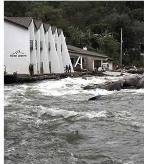
Ilustración 64. Afectaciones en hotel Ladera y Puente Panamonte, 2008. Fuente: Lloyd I. Cripe
