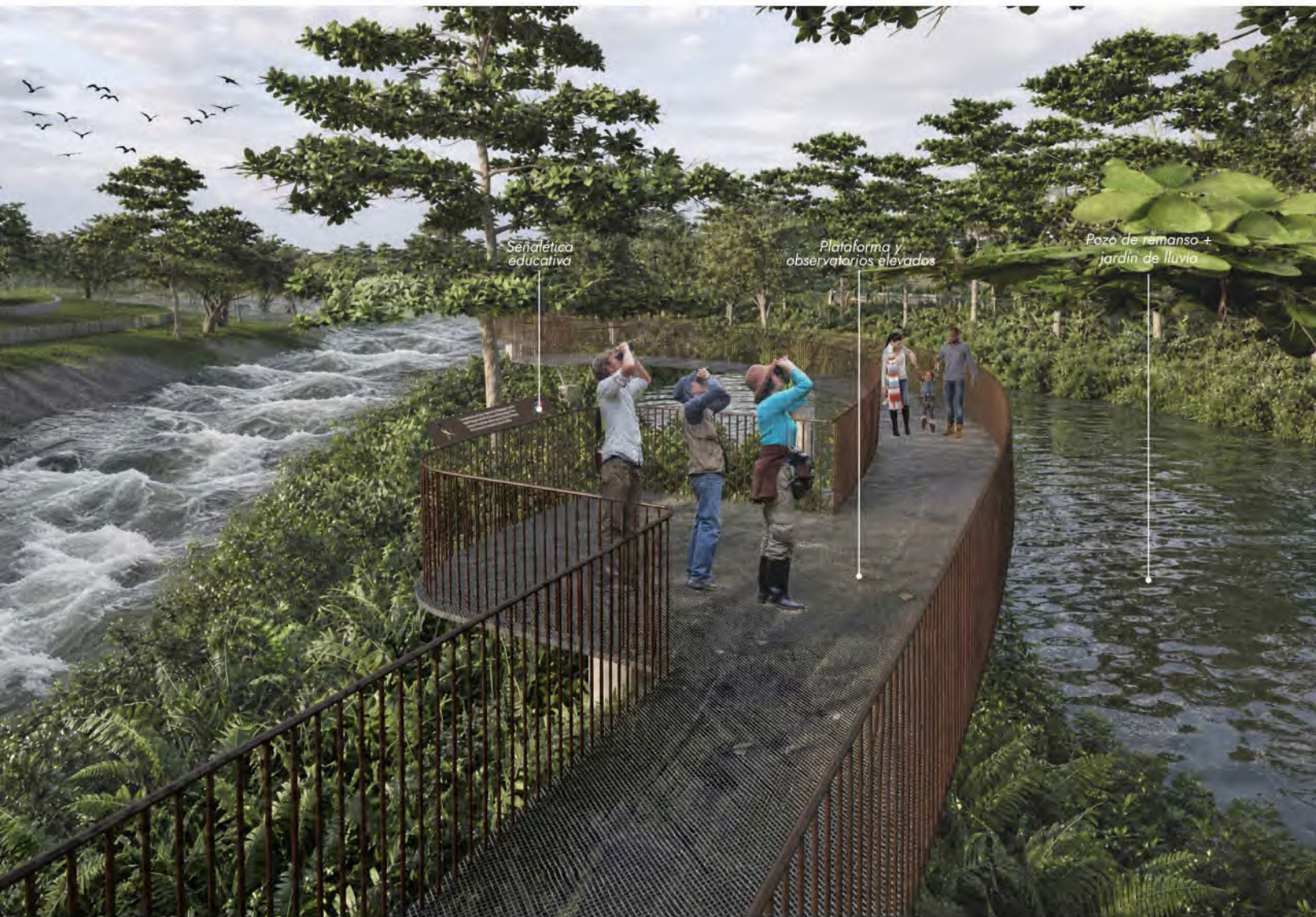
Ilustración 85. Observatorios elevados sobre el río Caldera, las pozas de remanso y los jardines de lluvia. Se observan la señalización educativa, la plataforma de PRFV soportada con estructura de metal y pedestal de concreto y la baranda con acabado bronce/cobrizo.
