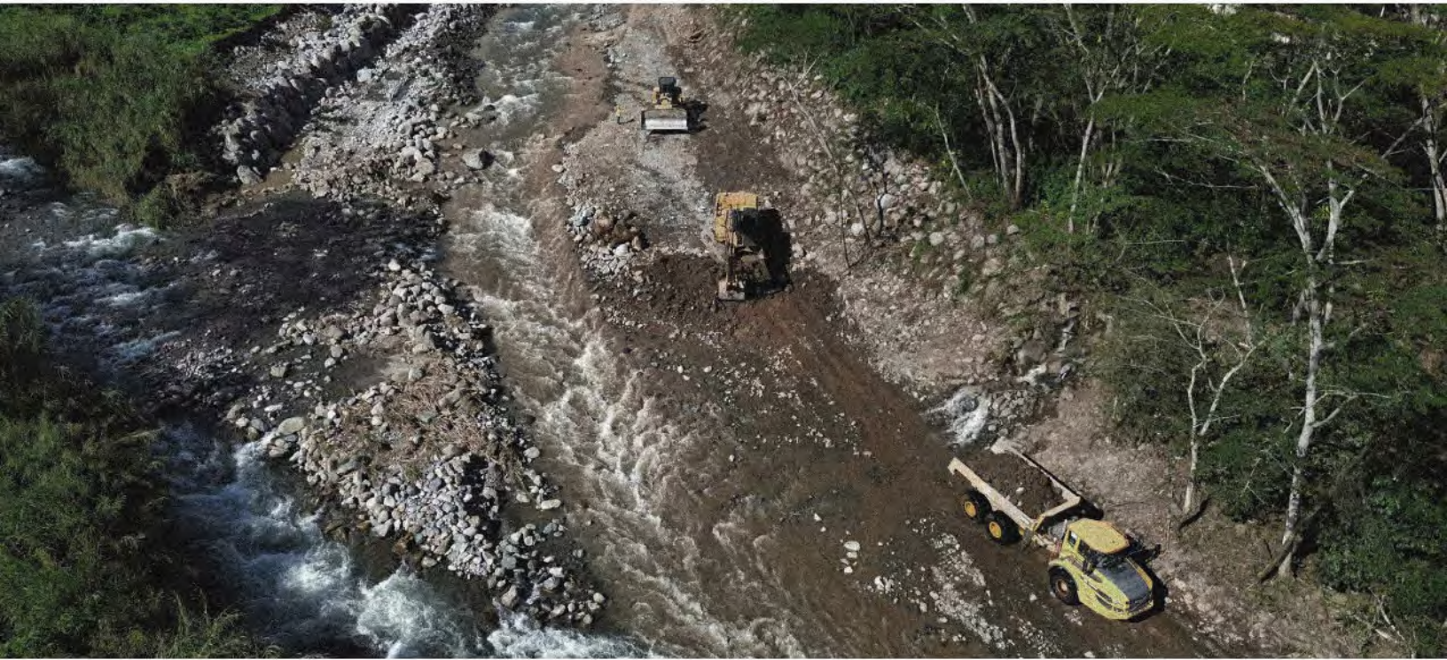
Ilustración 68. Trabajos de dragado y construcción de muros de contención en un tramo del río Caldera, en la confluencia con el río Pianista. En los laterales se observa el proceso constructivo de los muros de roca, así como el desgaste y alteración del propio lecho fluvial ocasionado por las intervenciones realizadas.
