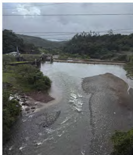
Ilustración 63. Bocatoma para desvío de caudal, hidroeléctrica La Estrella. Autoría propia.
