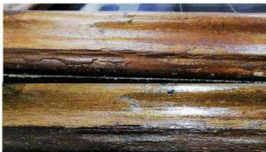
Figura 4. Comparativa del estado del marco antes (arriba) y después (abajo) de la intervención. Registro fotográfico propio, 2025.
