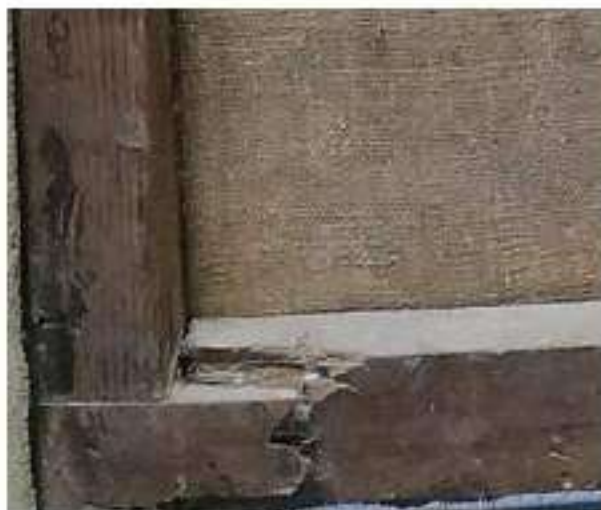
Figura 3. Deterioros en el bastidor y en el marco. Registro fotográfico propio, 2025.
