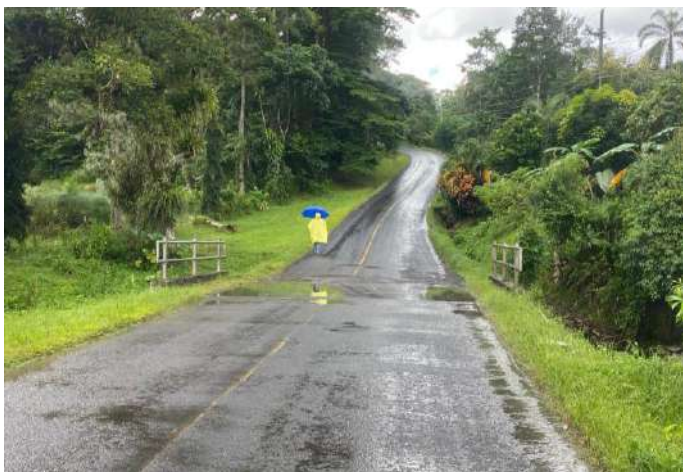
Figura 43. Vista carretera principal del sector
