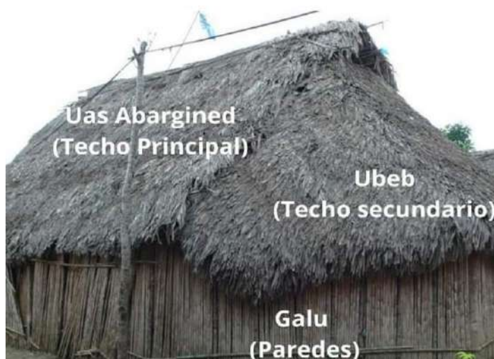
Imagen 39. Estructura de una casa Guna (Techos y paredes)
