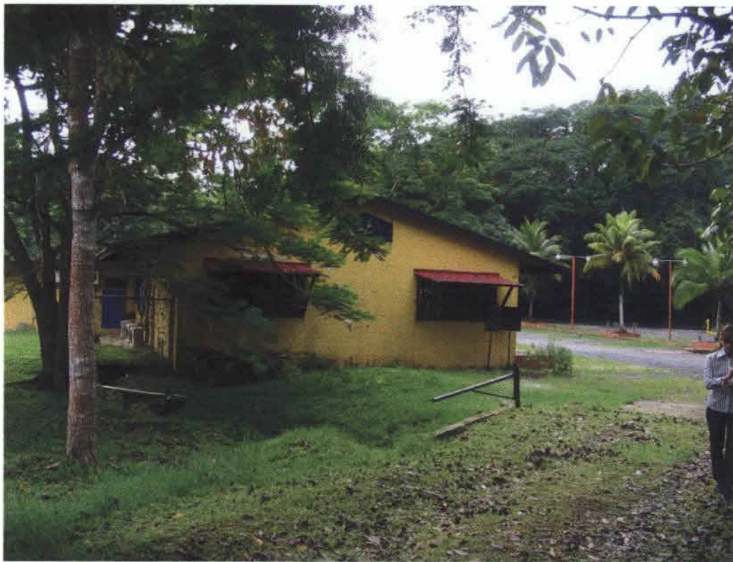
Foto 6. Vista Lateral Izquierda del Centro de Visitantes
