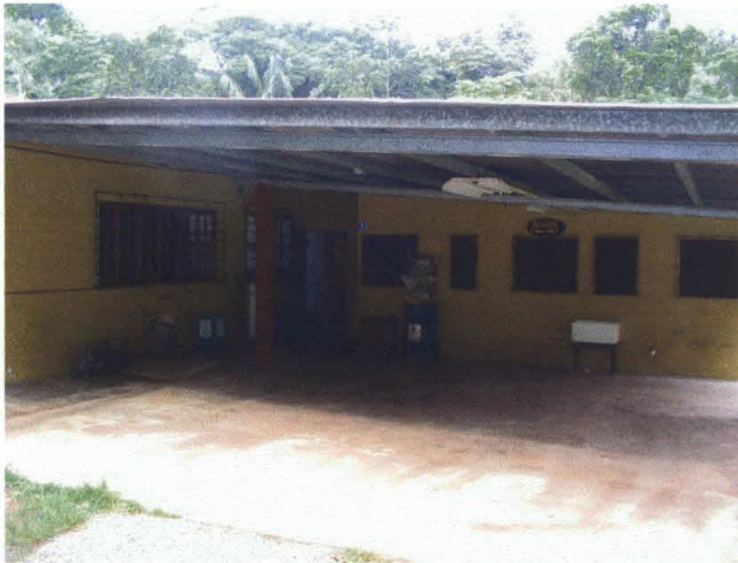
Foto 14. Estacionamientos de Directivos y Servicios Sanitarios (vista lateral derecha)
