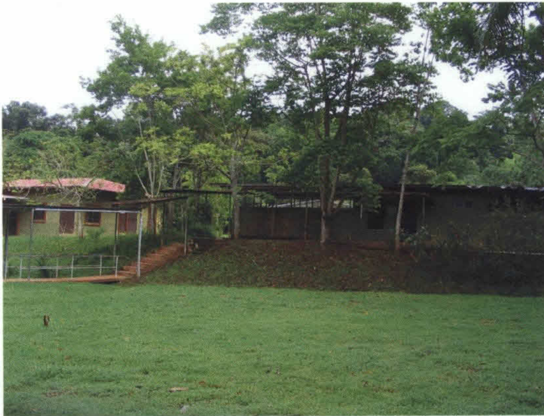
Foto 12. Edificio de dormitorio de guarda parques y Talleres de Educación Ambiental
