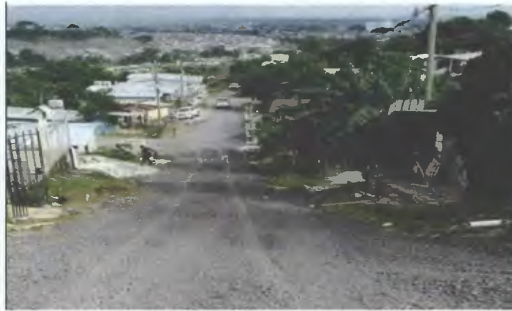
FIG. N°5. COMUNIDAD ALTOS DE LAS TORRES DESPUÉS DE LA CONSTRUCCIÓN DEL PROYECTO
