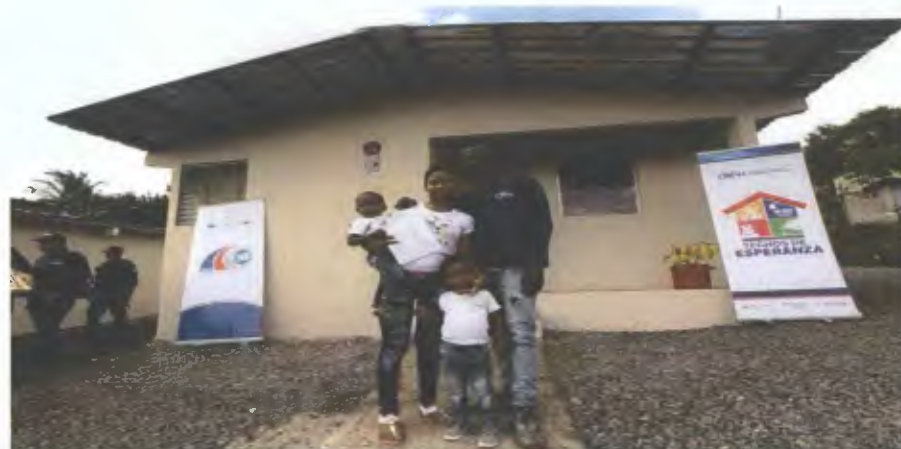
FIG. N°6. COMUNIDAD ALTOS DE LAS TORRES DESPUÉS DE LA CONSTRUCCIÓN DE LAS RESIDENCIAS
