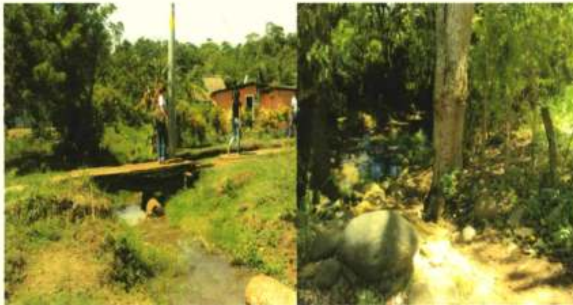
Encontramos un puente improvisado de tablonces para cruzar al área, cuando llueve crece y muchas veces impide el acceso de las familias a sus hogares y en otras ocasiones causa inundaciones por la cercanía del río.
