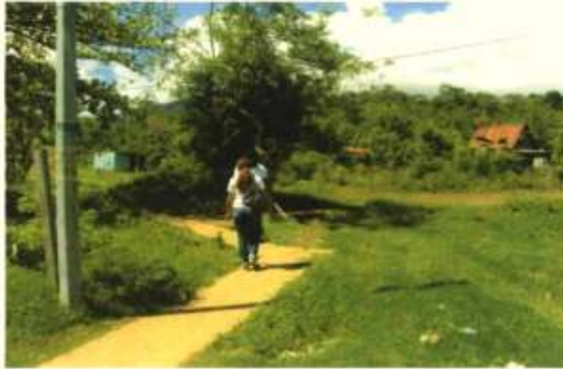
Esta es la acera que da inicio a la entrada a las viviendas de la Comunidad 31 de Octubre en Lidice, Capira.
