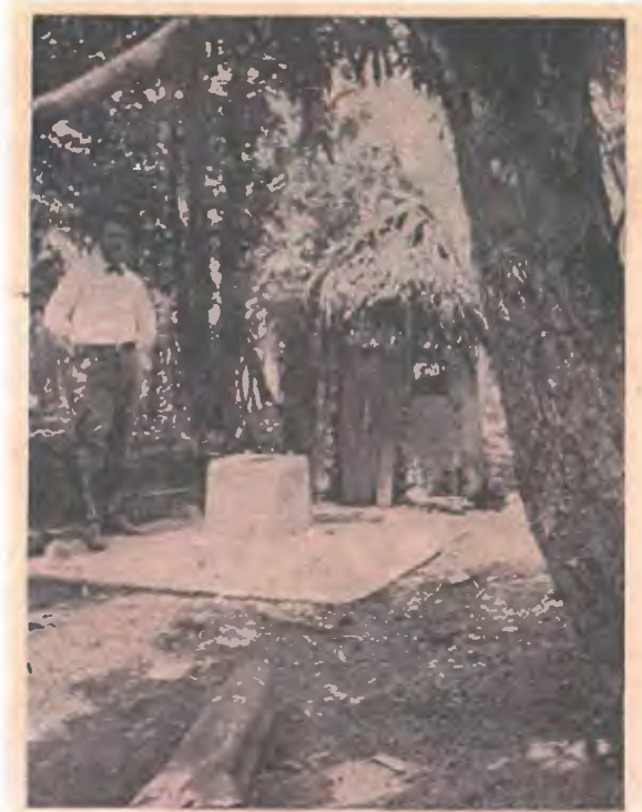
Fig. No.22: Avances en la construcción de un excusado
