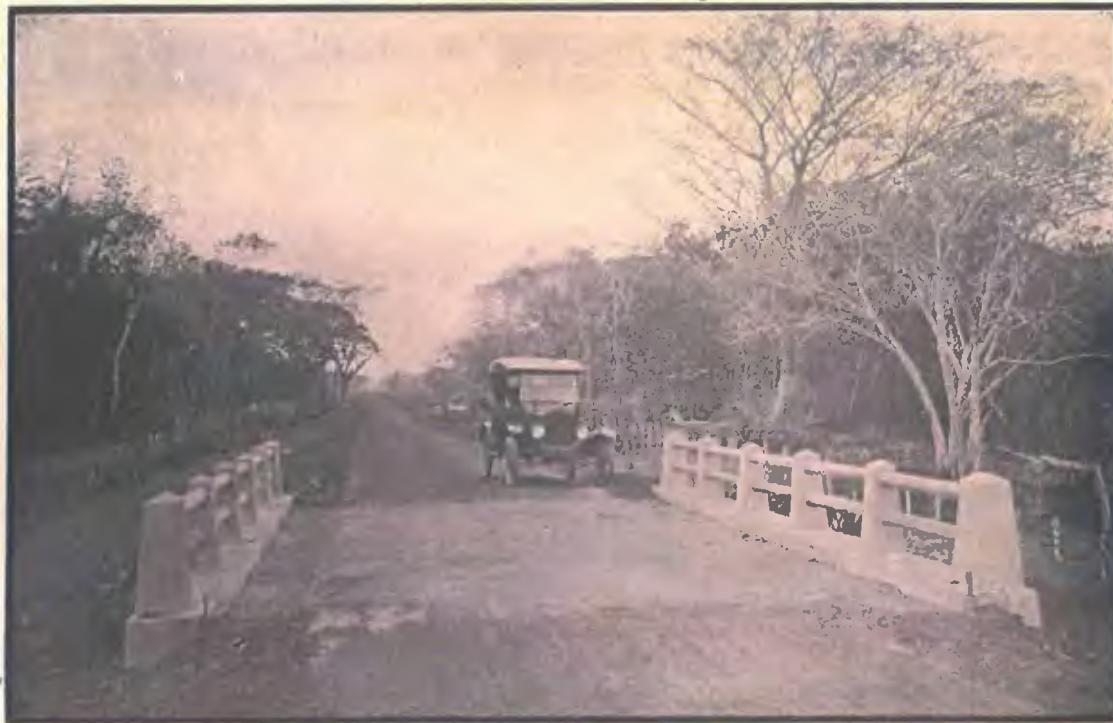
Fig. No.19: Avances de la carretera nacional. Fuente: Memoria de la Secretaría de Fomento, 1924
