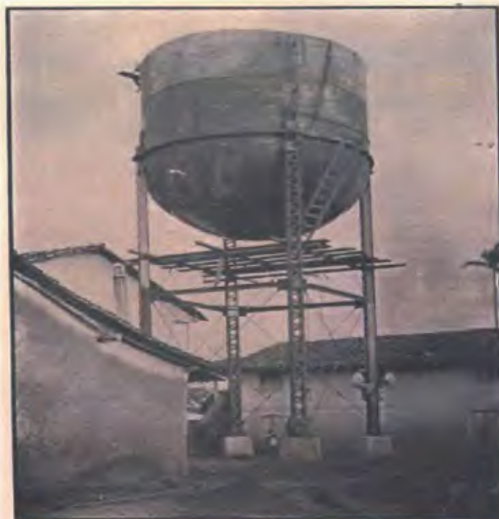
Fig. No. 26: Tanque del Agua, Acueducto de Penonomé. Fuente: Memoria de Fomento, 1924
