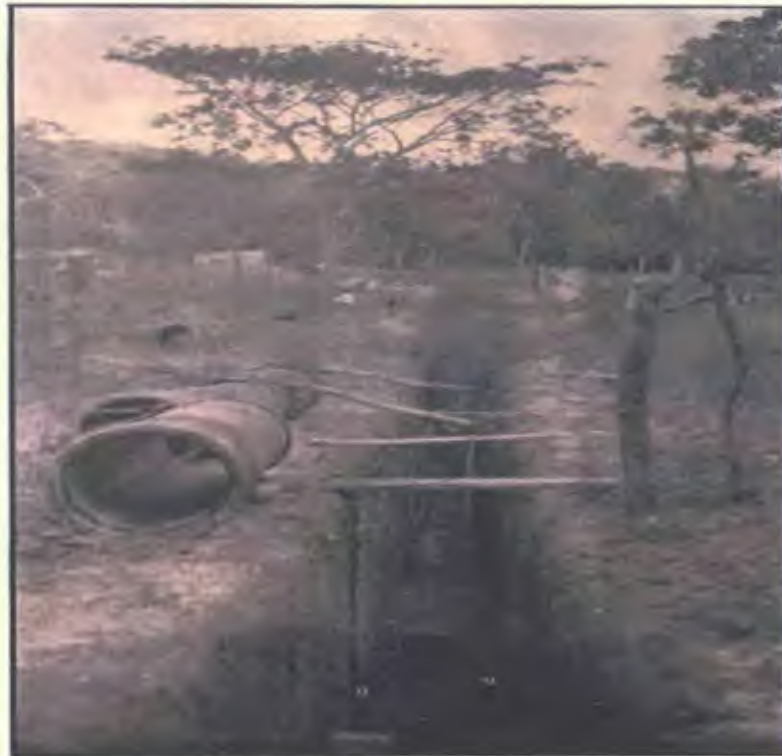
Fig. No. 25: Colocación de tubos, acueducto de Penonomé. Fuente: Memoria de la Secretaría de Fomento, 1924
