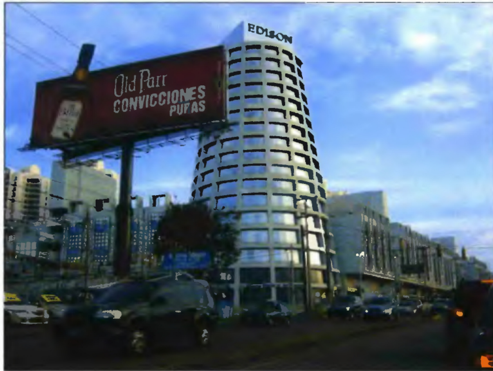
Figura N° 14: Oficinas del Ministerio de Vivienda.
