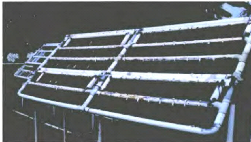
Figura 4.6 Estación Colón. Vista general de Láminas con 6 meses de Corrosión.
