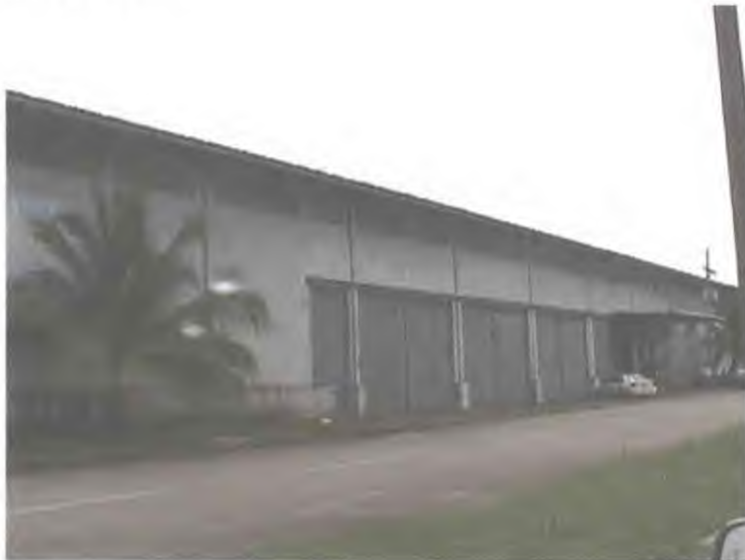
FOTO DE LA NUEVA BODEGA
