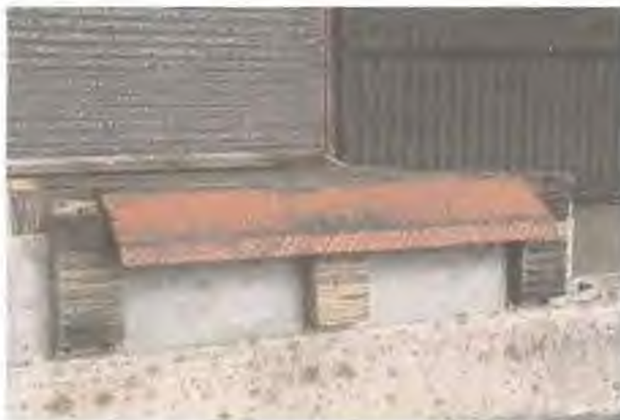
FOTO DE LA RAMPA DE LA TERCERA BODEGA
