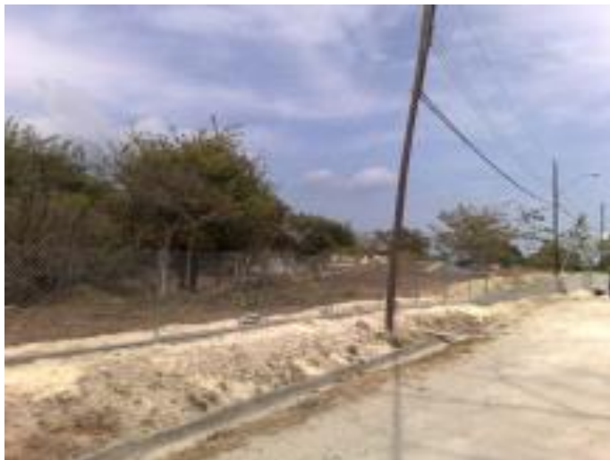
Ilustración 16 Cunetas en los costados de las calles
