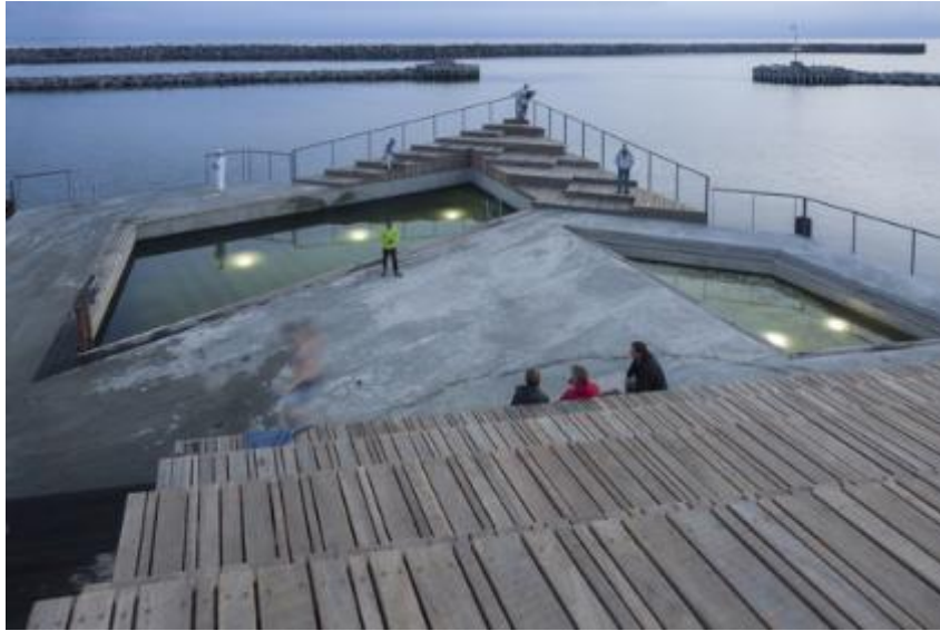
Ilustración 21: Baños en el puerto de Hasle, Dinamarca
