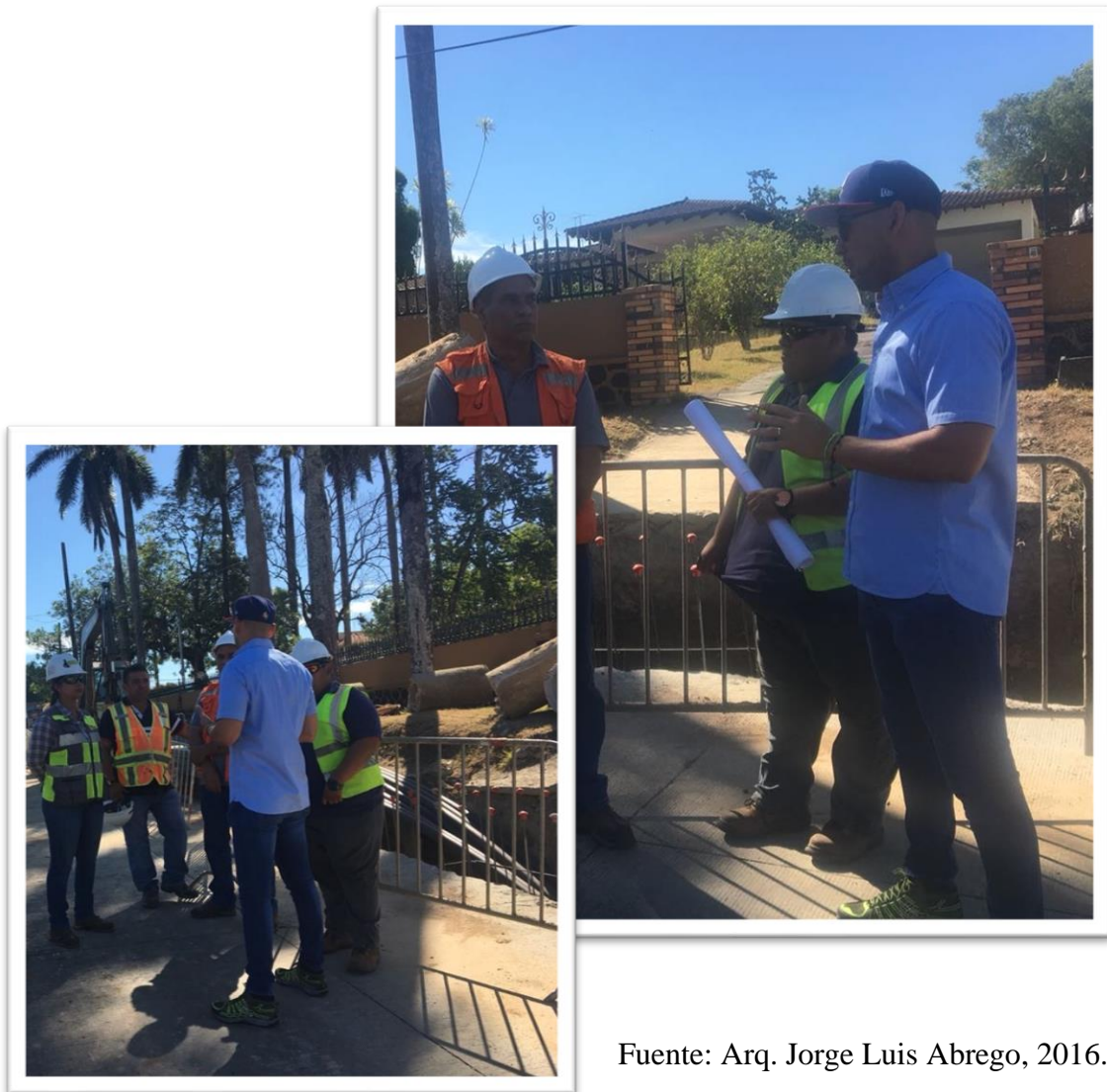
Figura #8: Proyecto de soterramientos de cables, Santiago.
