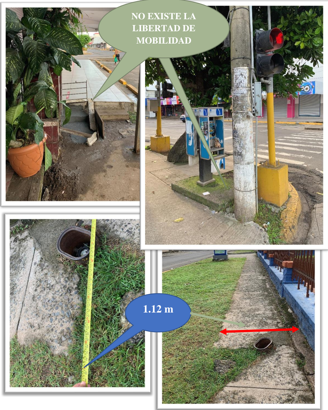
Figura #21: Levantamiento físico y fotográfico, por calles 9na. y 10ma.
