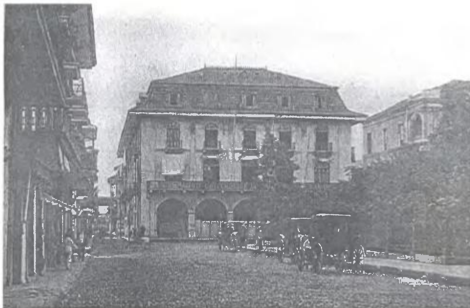
La plaza Catedral ya cercada y con vegetación. Al fondo el edificio de la Compañía Universal del Canal.
