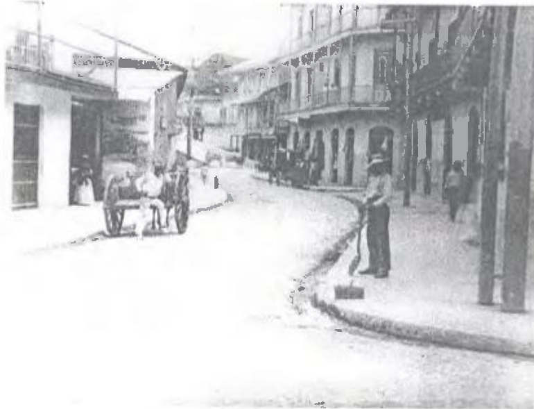
Avenida Norte después de la pavimentación. Agosto de 1907.
