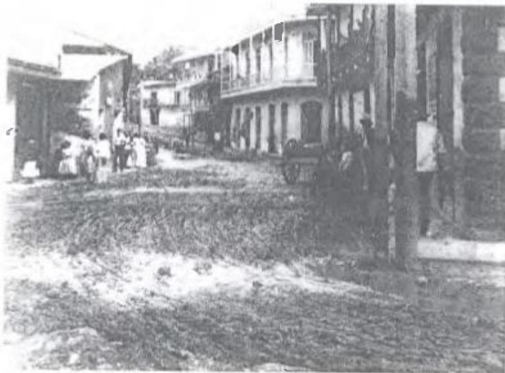
Avenida Norte antes de la pavimentación. Junio de 1907.
