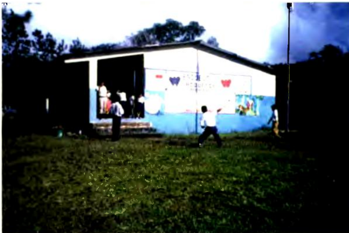
Fotografía No. 1. Aspecto general de la Escuela Boquerón Abajo.
