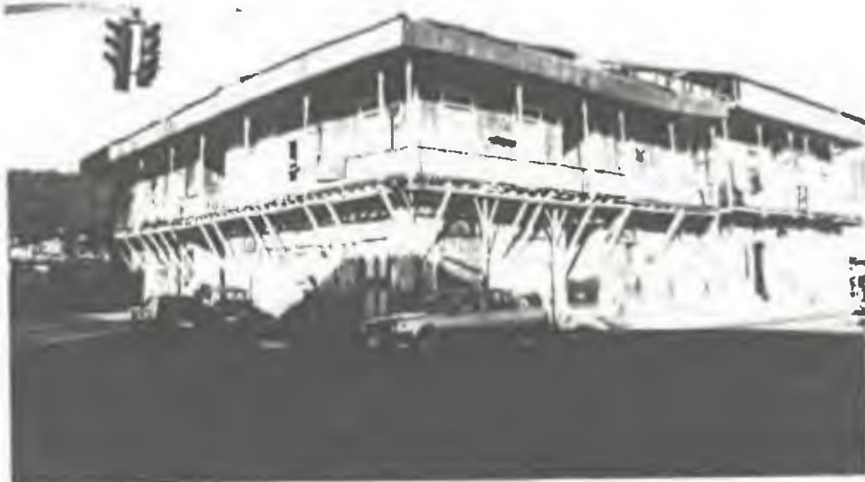
11 Aspecto de casa condenada ubicada en el Barrio del Marañón, Corregimiento de Calidonia.
