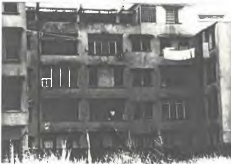
13 Edificio de mampostería de cuatro pisos en el Corregimiento de Calidonia, apartamentos donde residen pacientes de Tercera Edad.
