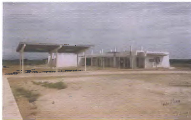
Foto N° 8. Primera Fase construcción de la Extensión Universitaria de Aguadulce.
