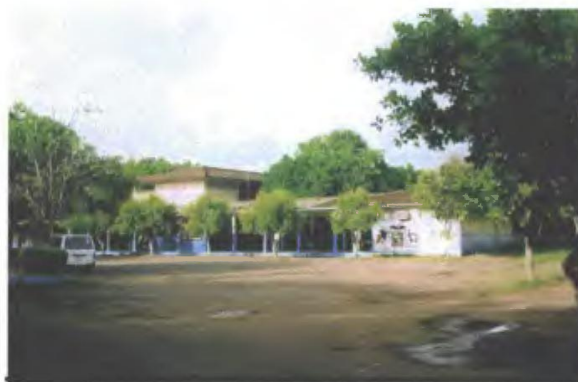
Colegio Rodolfo Chiari Edificio construido en 1959.
