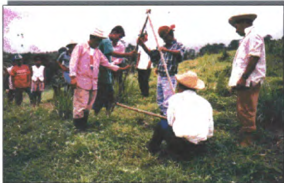
Foto 17 – Aporte de Mano de obra en Construcción de Curvas de Nivel
