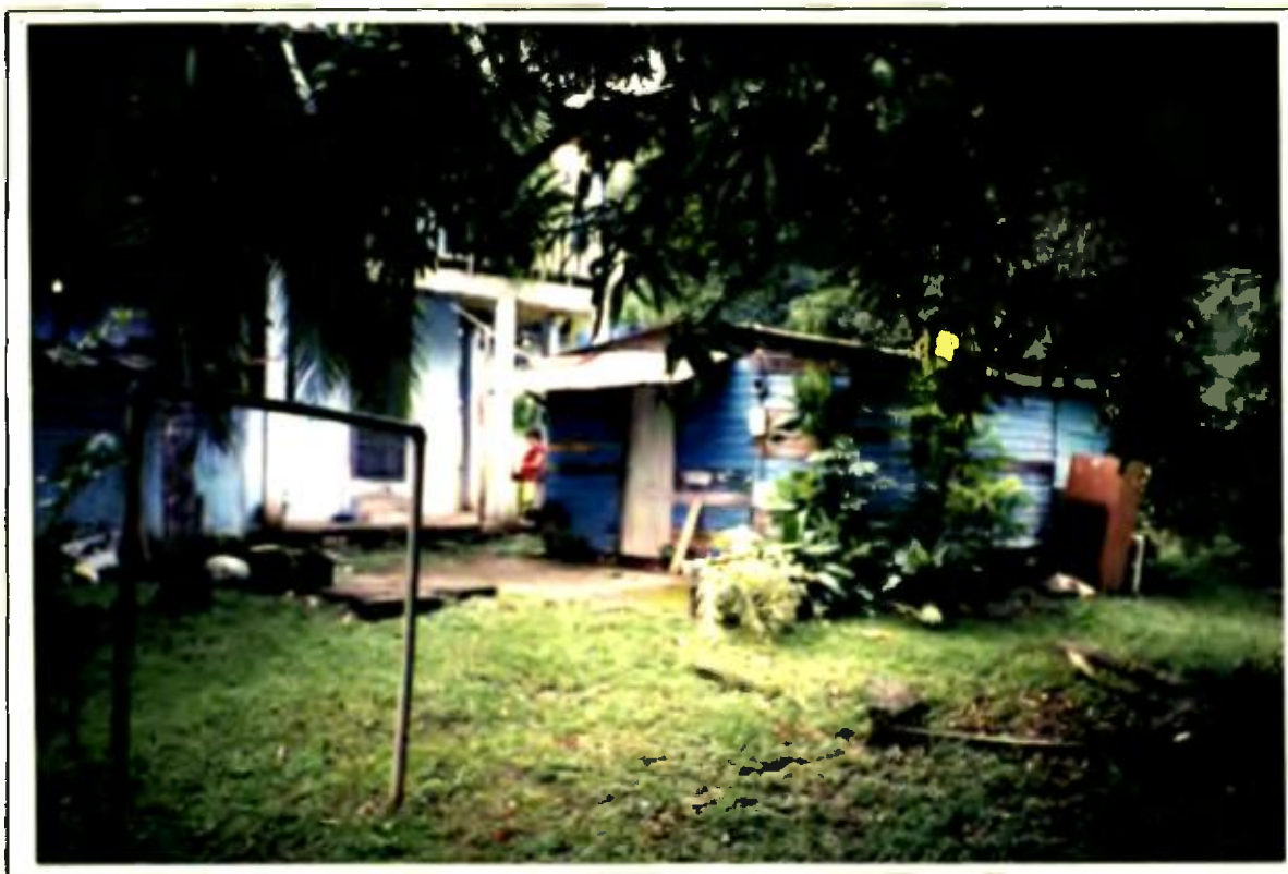
FOTOGRAFÍA N°23 Vivienda de madera en San Antonio, algunas de las cuales observan condiciones precarias.
