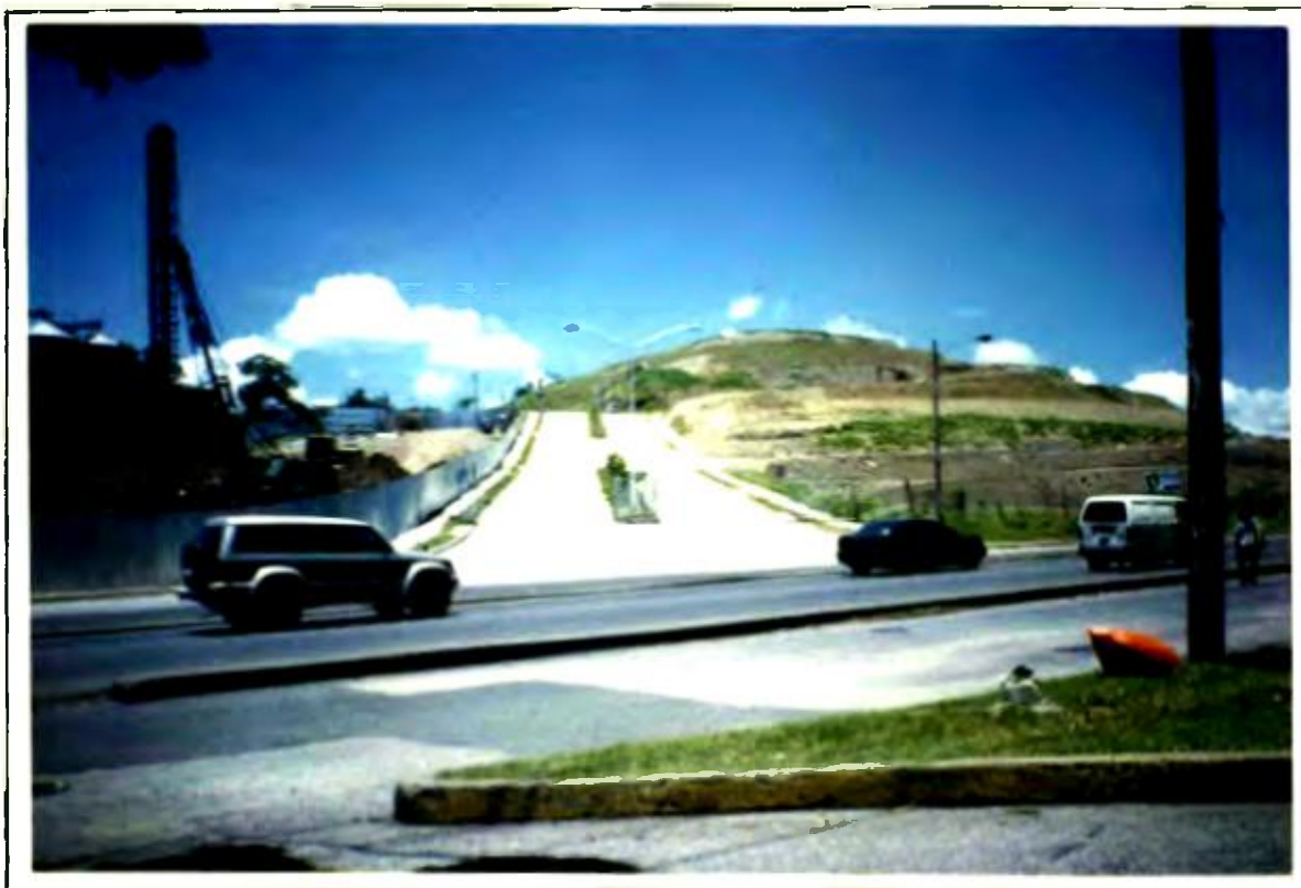
FOTOGRAFÍA N°4 Área baldía en Cerro Loma Fruta de la Pava, espacio sometido a intensos trabajos de nivelación para su ocupación.
