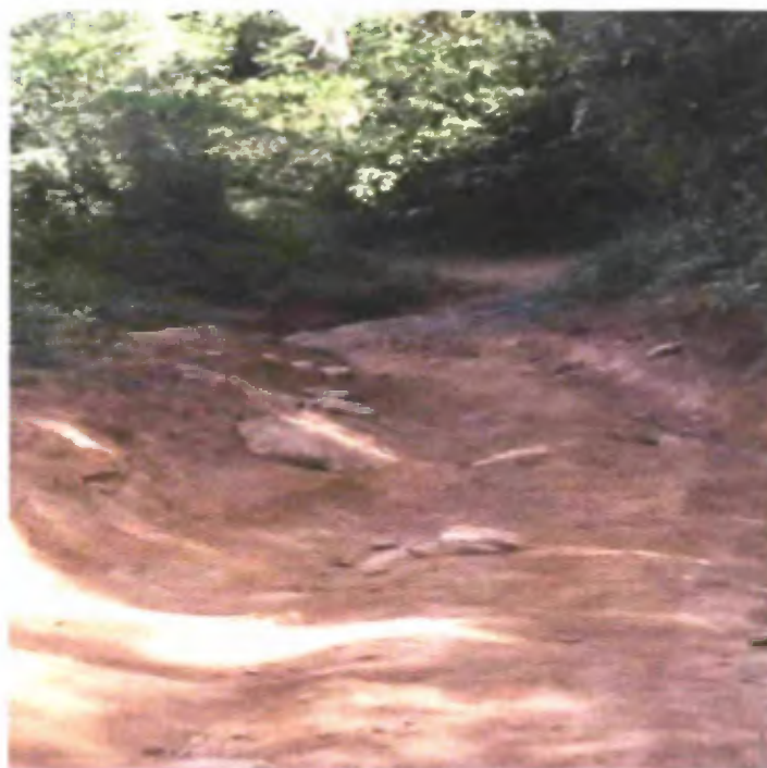
Foto N°20. Vista de la carretera hacia el corregimiento de Hato Corotú.
