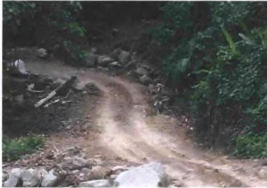
Foto N°17. Vista de la carretera en donde hubo un deslizamiento de rocas que interrumpió el tránsito por unos días.
